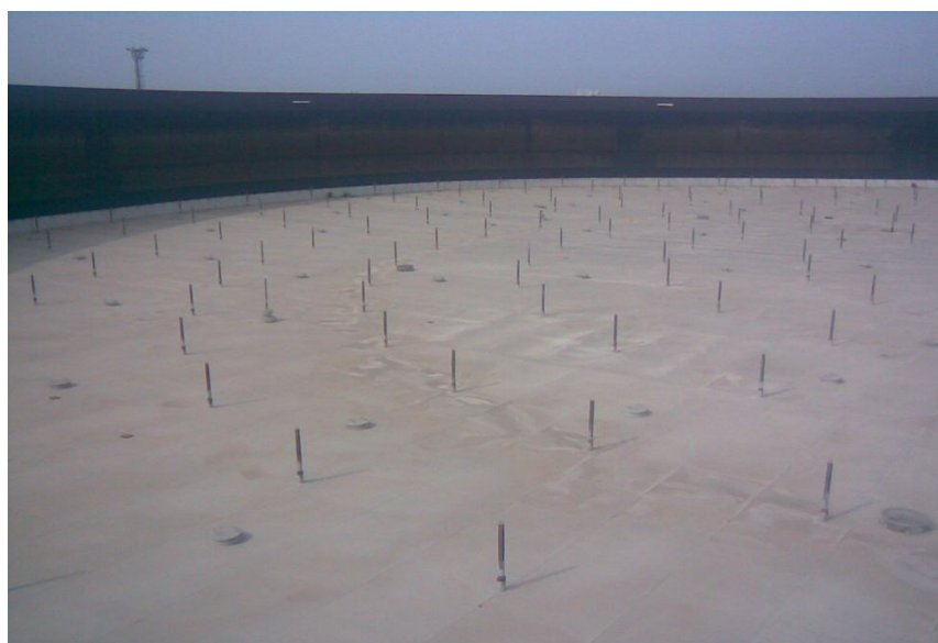
شکل (۷-۶) نمایی دورتر از پایه های سقف مخزن ۲۸ جزیره خارک
