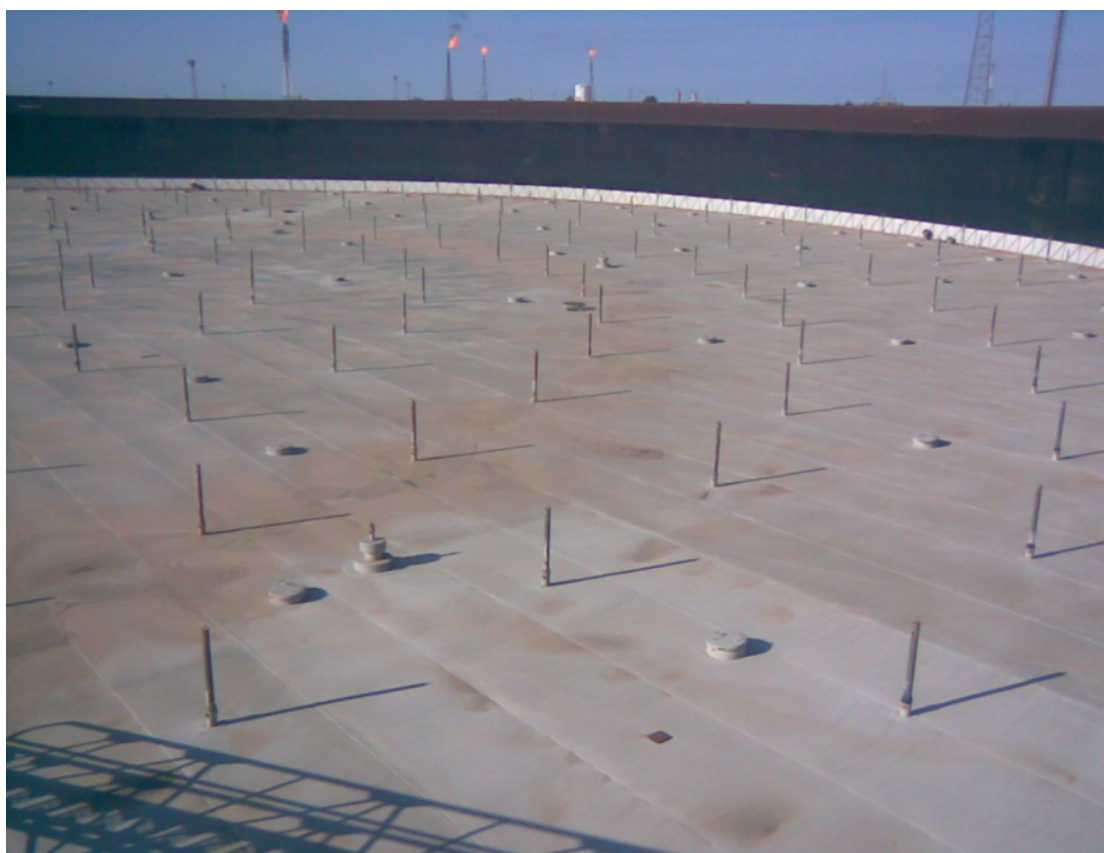
شکل ۳-۹- نمایی از سقف مخزن
