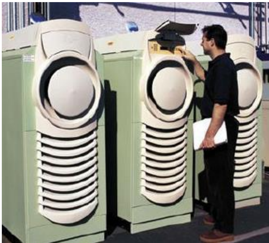
شکل ۳-۱: نمایی از سه دستگاه میکروتوربین گاز نصب شده
