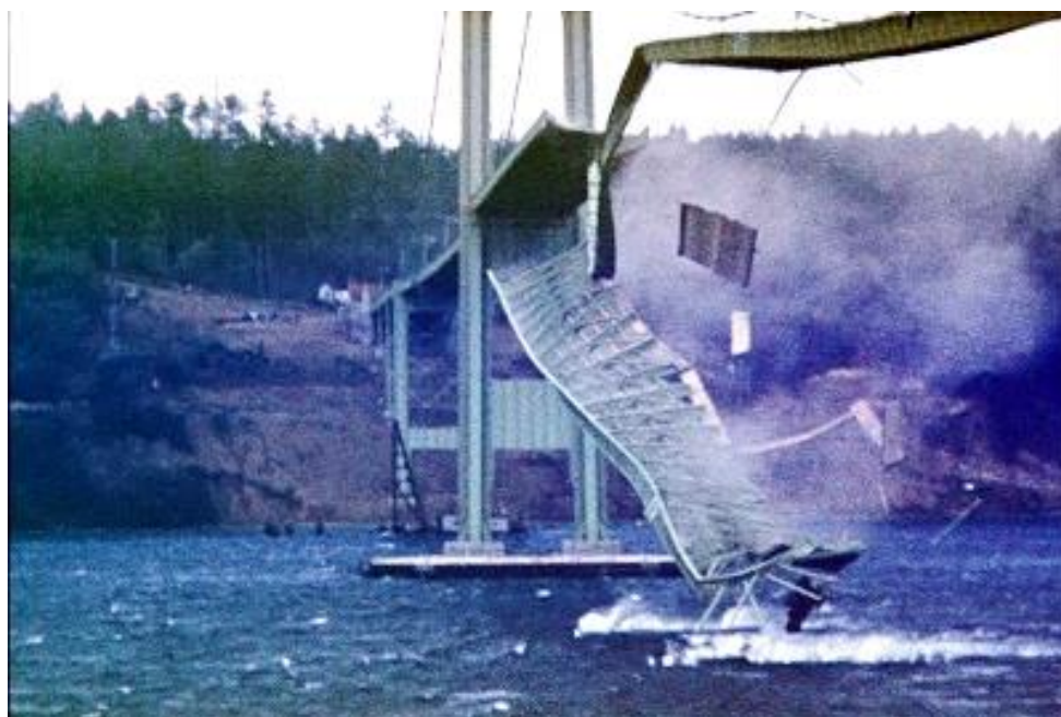
شکل ۱-۳ عکس از تخریب پل تاکوما در ۱۹۴۰ توسط ارتعاشات ناشی از گردابه‌ها [64]
