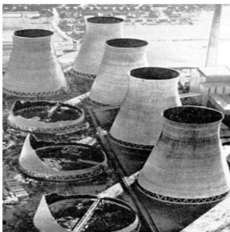
شکل ۱-۴ تخریب برج خنک کن‌های فری بریج توسط ارتعاشات ناشی از گردابه‌ها [64]
