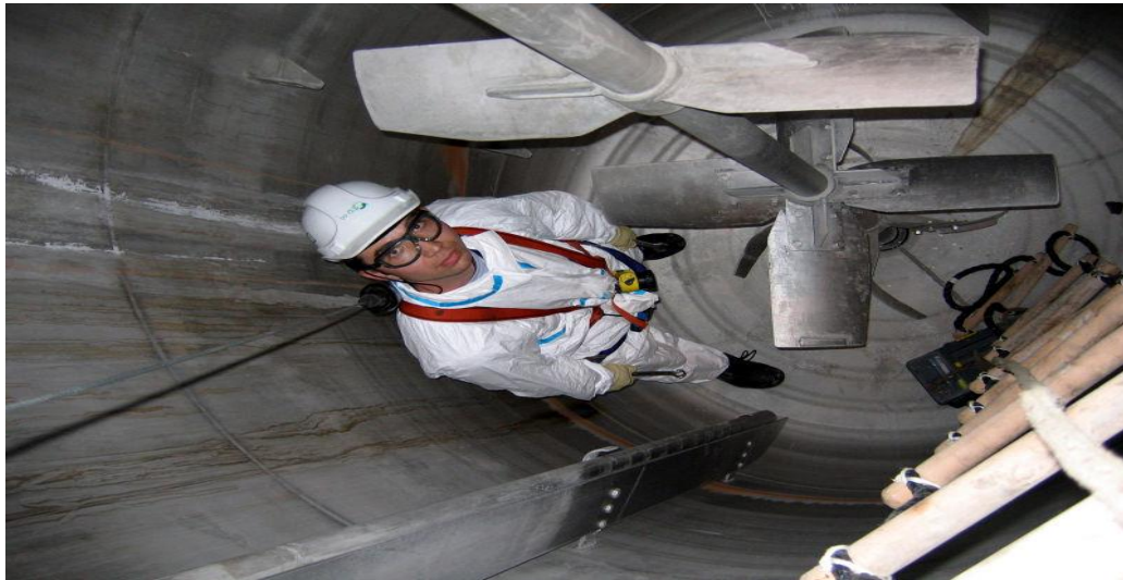
شکل ۱-۲: محیط داخلی یک رکتور مخزنی (CSTR)
