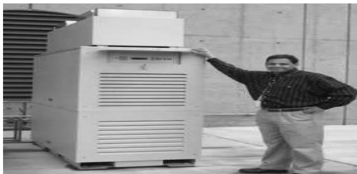
شکل (۷-۱): نمونه‌ای از یک میکرو توربین ۶۰ کیلو واتی [۱۱]
