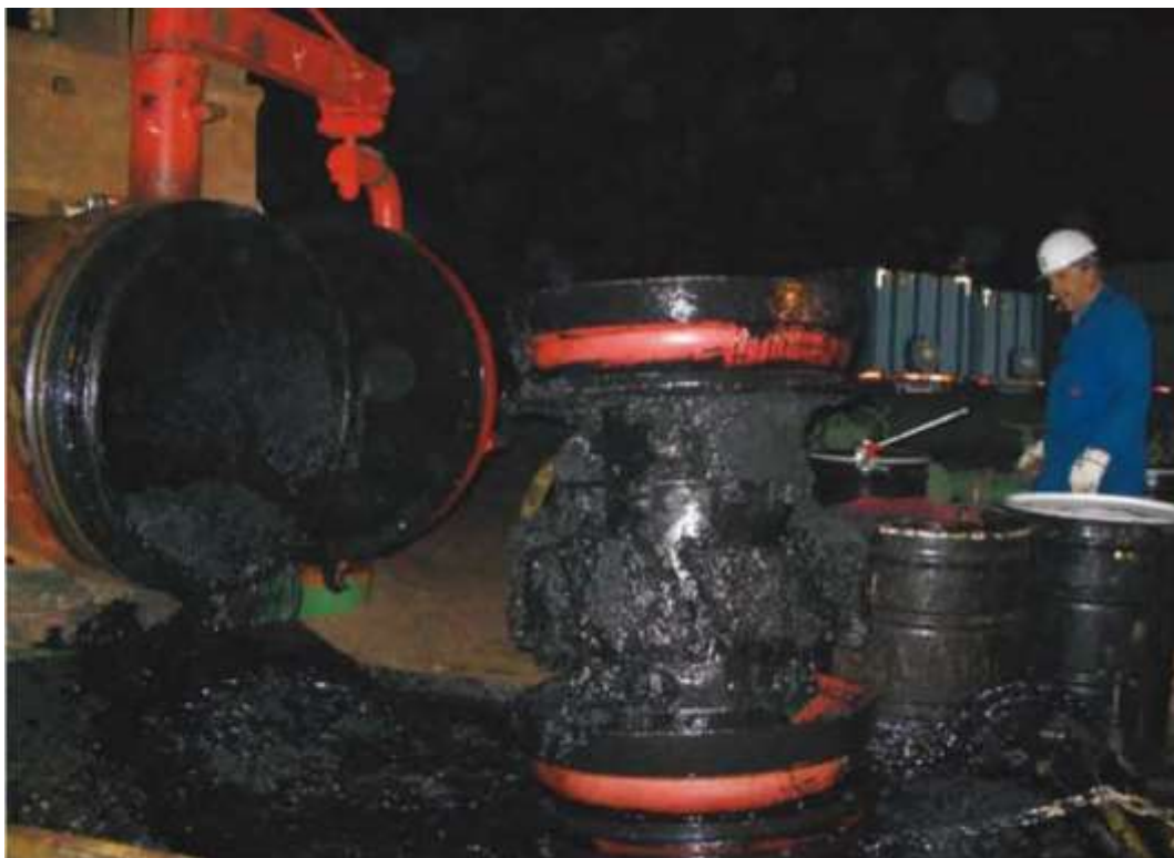
شکل ۳-۲ خروج ناخالصی‌ها پس از اجرای عملیات پیگرانی در خطوط توزیع گاز [۲۳]
