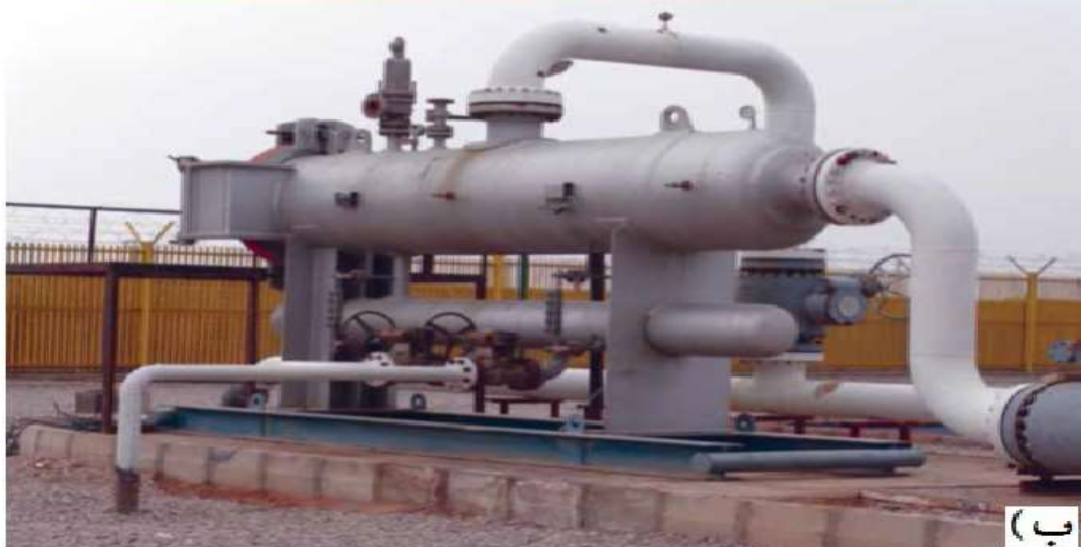
شکل ۳-۹ نمایی از فیلتر سپرایتورها در ایستگاه گاز طبیعی (الف) نوع عمودی (ب) نوع افقی [۳۱]
