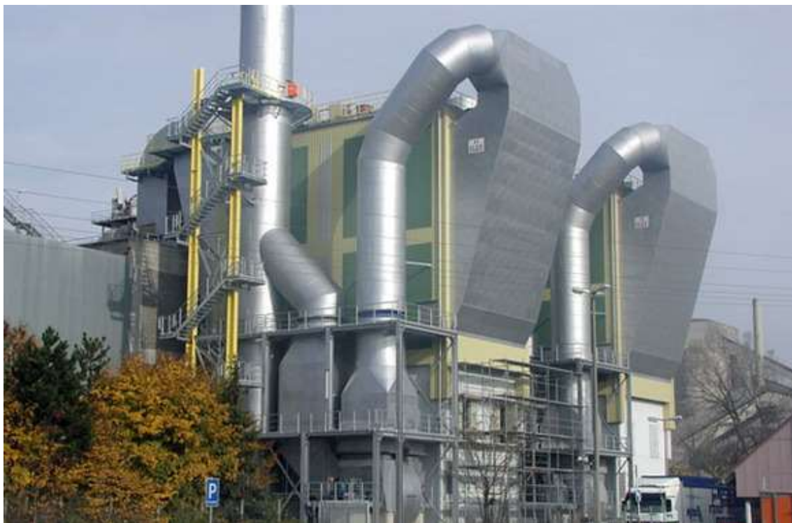
شکل ۳-۵ الکتروفیلترهای کارخانه‌ی سیمان در آلمان [۲۶]
