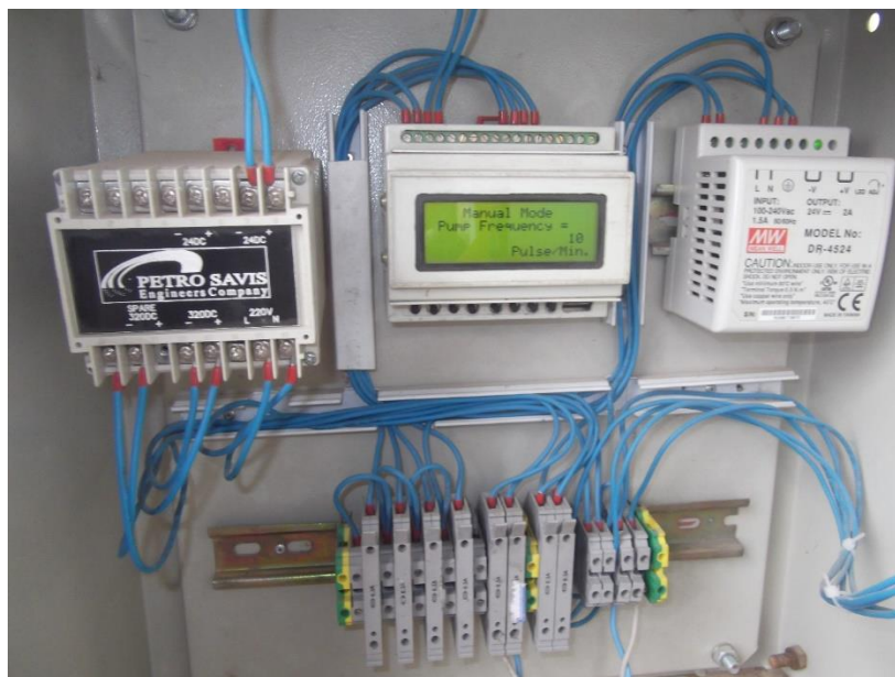
شکل ۲-۶: سیستم کنترلی تزریق
