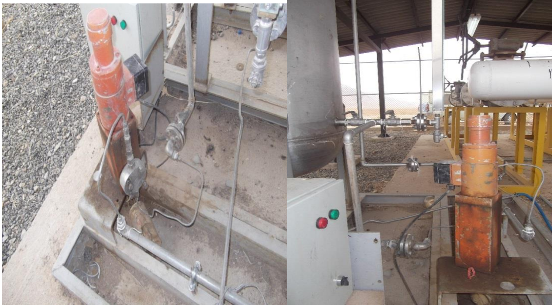
شکل ۲-۳: محل و نحوه قرارگیری پمپ دیافراگمی
