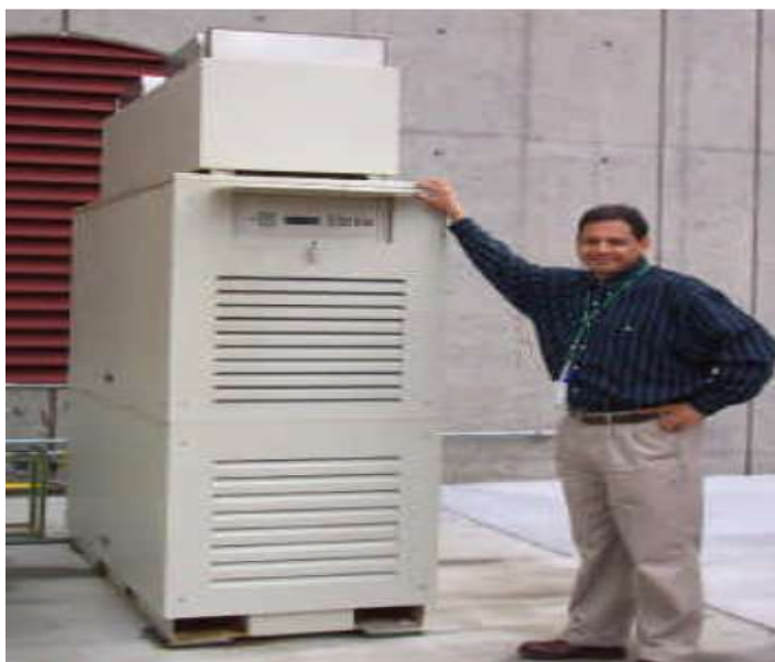
شکل (۸-۱): نمونه‌ای از یک میکرو توربین ۶۰ کیلو واتی [۱۰]
