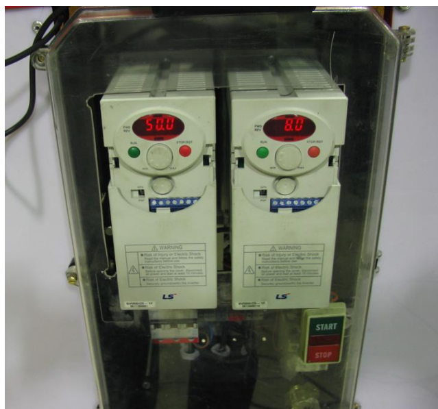
شکل (۵-۱۰) سیستم کنترل و اینورترهای استفاده شده در دستگاه [۸۱].
