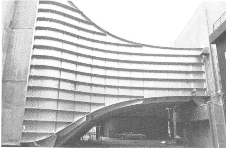
شکل (۲-۹) نازل تونل باد
