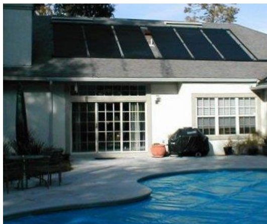
شکل ۲-۱۶- تصویری از یک سیستم گرمایش آب استخر
