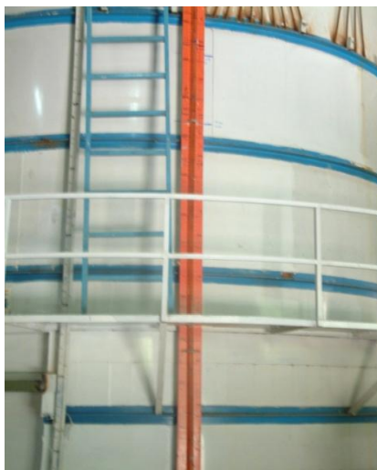
شکل ۳-۱۱: نمایی از مانومتر قائم متصل به مخزن برای اندازه‌گیری ارتفاع آب مخزن
