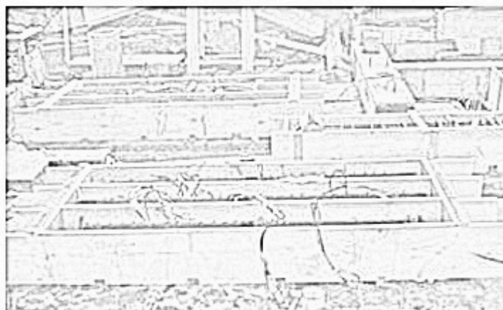
۲- قرار دادن قفسه آزمایشیها درین قالب‌ها
