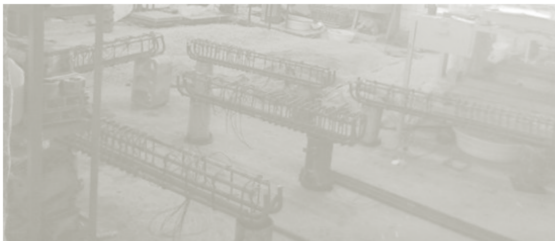
شکل 3-4: آرماتور بندی تیرها
