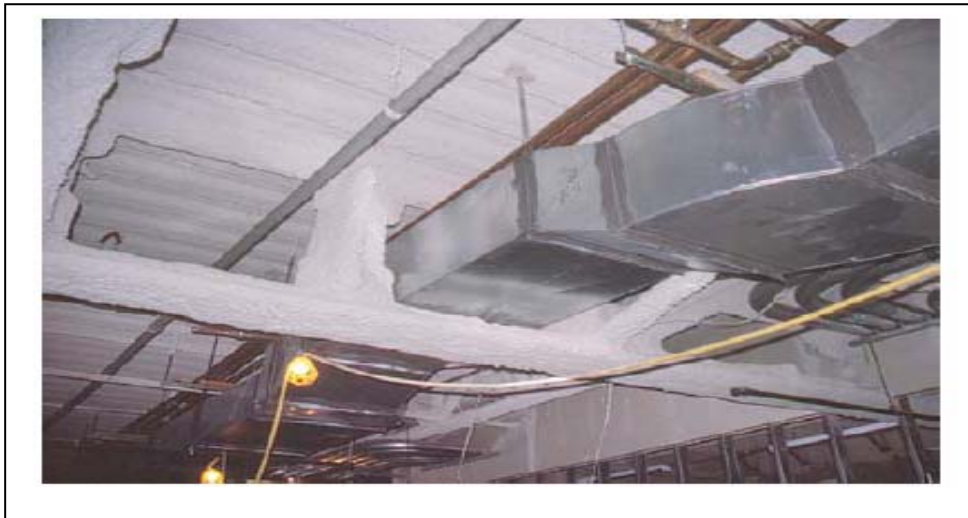
شکل ۲-۳: داکت عبوری از پانل ویرندیل
