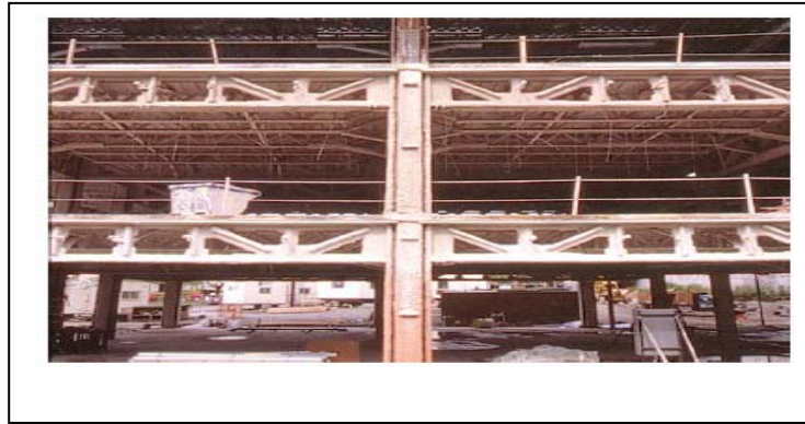
شکل ۲-۲: قاب خمشی خرپایی ویژه با دو پانل ویرندیل در نواحی ویژه
