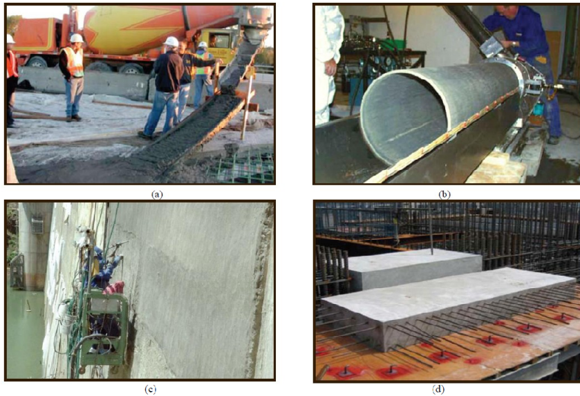
شکل ۴-۷: شیوه‌های پرداخت ECC (a) قالب‌ریزی خودمتراکم، (b) روزن‌رانی، (c) بتن پاشی، (d) پیش‌ساختگی.
