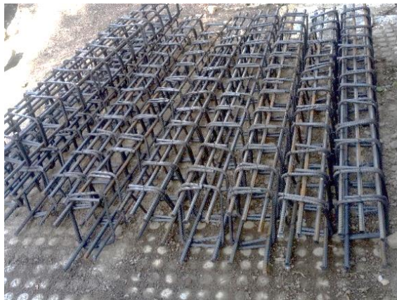
الف) قفسه‌های آرماتوربندی شده و نمونه‌های آزمایشگاهی
