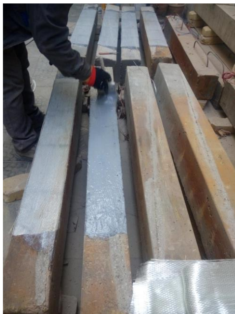
شکل ۳-۱۵: چسباندن ورقهای پلیمری شیشه به تیر (GFRP)
