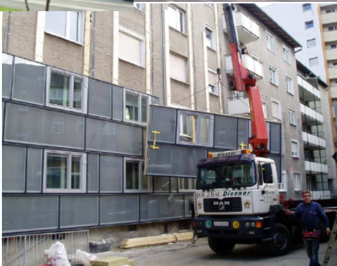
شکل ۲-۳- کاربرد هانی کمب بعنوان ترمیم در نمای ساختمان
