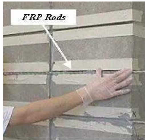
شکل ۴-۶- نحوه تقویت نمونه‌ها [۵]
