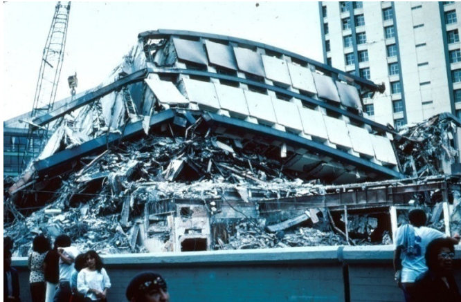
شکل ۱-۱ واژگونی سازه به طور کامل در زلزله ۱۹۸۵ مکزیکوسیتی
