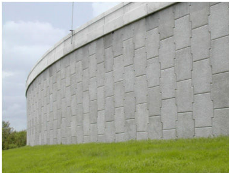
شکل ۲-۵ دیوار حائل یک پل قوسی
