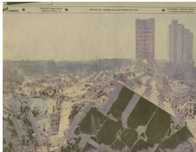
شکل ۲-۱ جداسدن سازه از فنداسیون در زلزله ۱۹۸۵ مکزیکوسیتی
