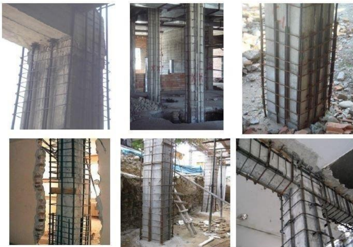
شکل (۲-۸) مقاوم سازی با ژاکت بتنی
