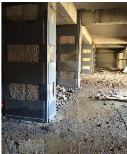
شکل (۷-۲) مقاوم سازی با ژاکت فولادی
