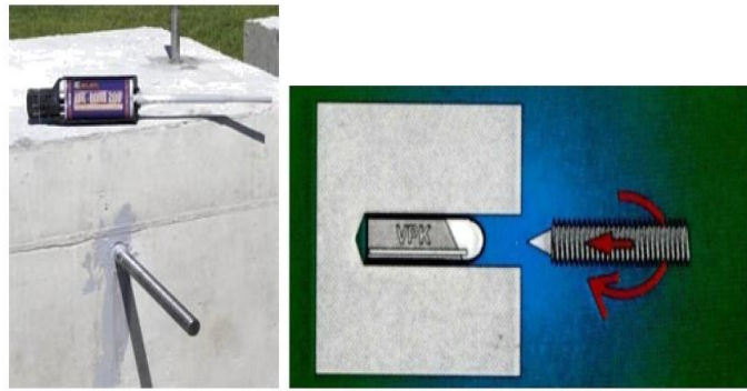
شکل (۲-۱۲) اتصال شیمیایی
