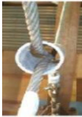
شکل (۲-۱۸) سیستم مهاربند کابلی با استوانه مرکزی [۷]
