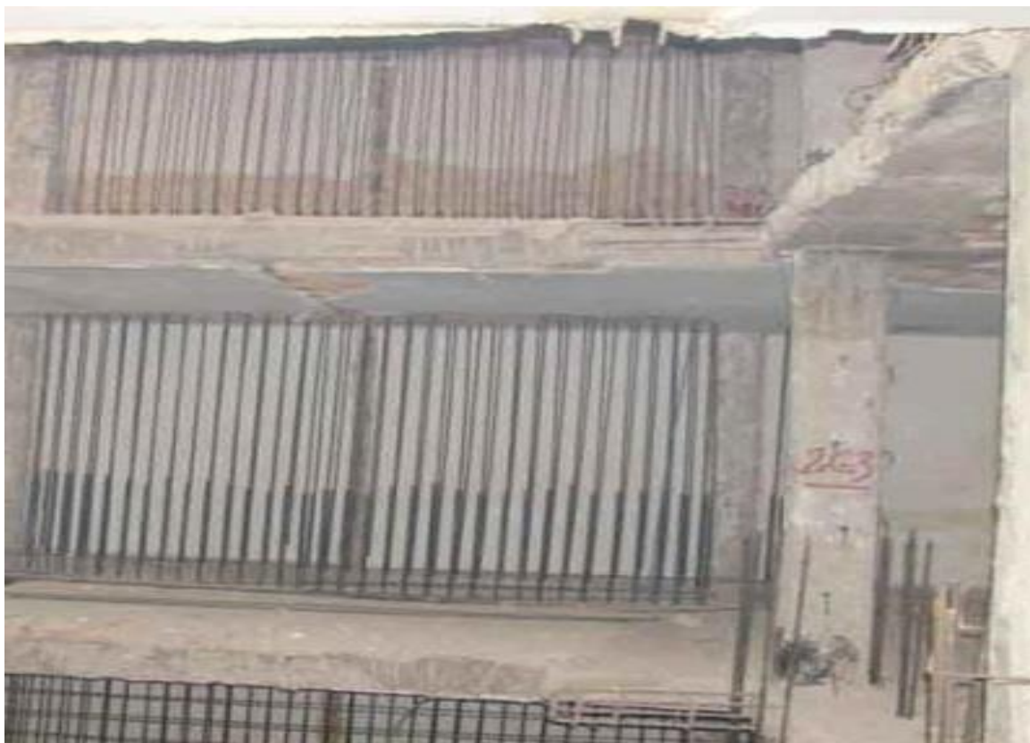
شکل (۲-۱۴) مقاوم سازی قاب بتنی با دیوار برشی
