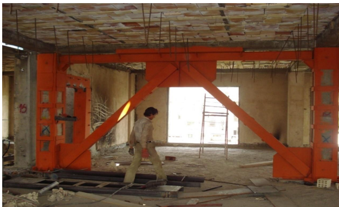
شکل (۲-۱۱) مقاوم سازی قاب بتنی با بادبند فلزی به روش مستقیم
