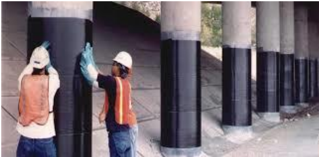
شکل (۹-۲) مقاوم سازی با استفاده از الیاف FRP
