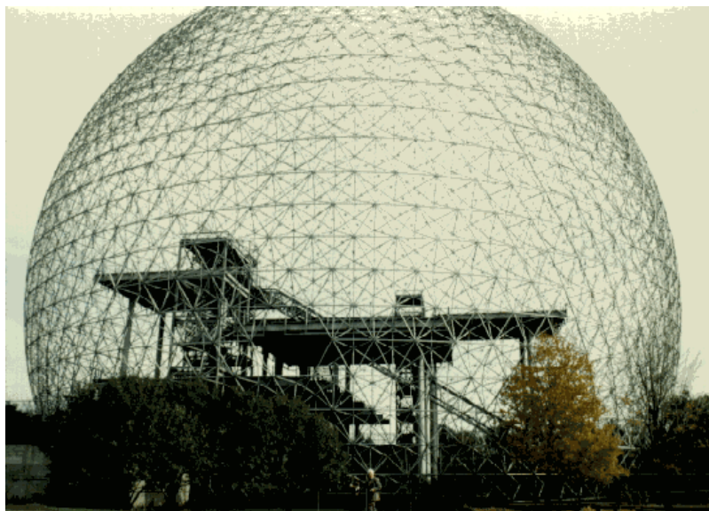
شکل 3-8: سازه‌ی سه چهارم کره‌ای باکمینستر فولر به قطر 76 متر
