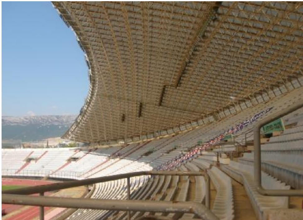
شکل 3-14: سقف جایگاه تماشاچیان در استادیوم اسپلیت
