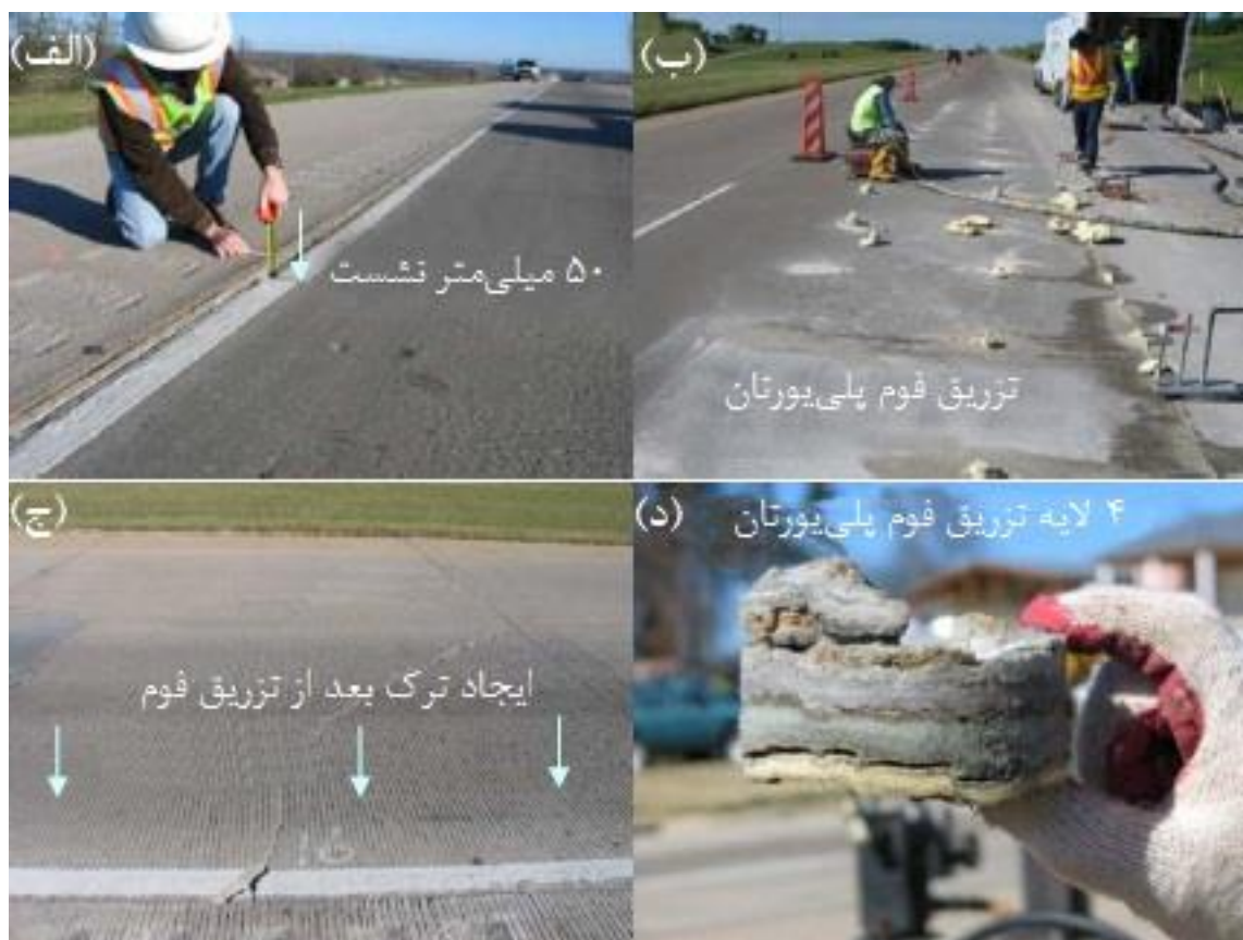
شکل ۲-۵: نشست جاده و تزریق فوم پلی‌یورتان [۲۶]
