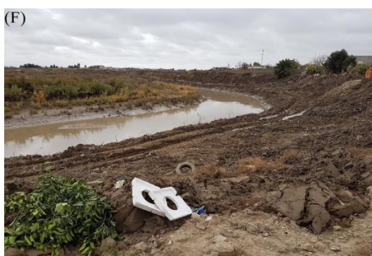
شکل ۴-۱۷: (A) صحت‌سنجی سری زمانی پهینه‌های سیلاب بدست آمده با تصاویر هوایی، (B) مسیر رودخانه در بازه اول در نزدیکی روستای سلاق یلقی، (C) پل نامناسب در مسیر رودخانه در بازه دوم در نزدیکی شهر آق‌قلا، (D) تراز کف نامناسب پل و عدم لایروبی رودخانه در بازه سوم شهر آق‌قلا، (E) عدم دیواره‌سازی مناسب رودخانه در بازه سوم پل تاریخی آق‌قلا، (F) نبود شیب مناسب و تخلیه نخاله در حریم رودخانه و عدم دیواره‌سازی کانال در بازه چهارم، (G) تغییر شدید عرض رودخانه و شیب نامناسب و عدم لایروبی رودخانه در بازه‌ی چهارم
