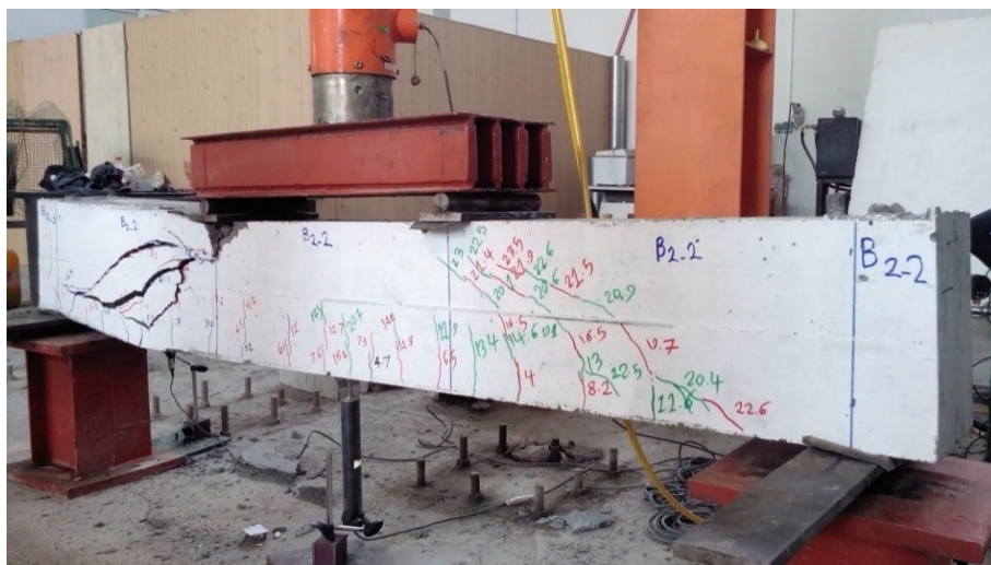
شکل ۵-۱۹ شکل خرابی برشی نمونه B ۲-۲
