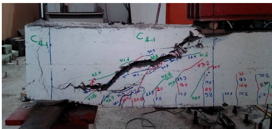
شکل ۷- شکل خرابی برشی نمونه C۴-۱
