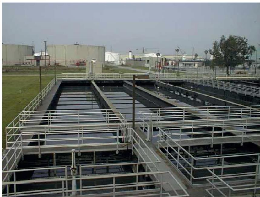
شکل ۲- ۵ نمونه هایی از استخرهای ته نشینی اولیه دایره ای و مستطیلی در یک تصفیه خانه فاضلاب
