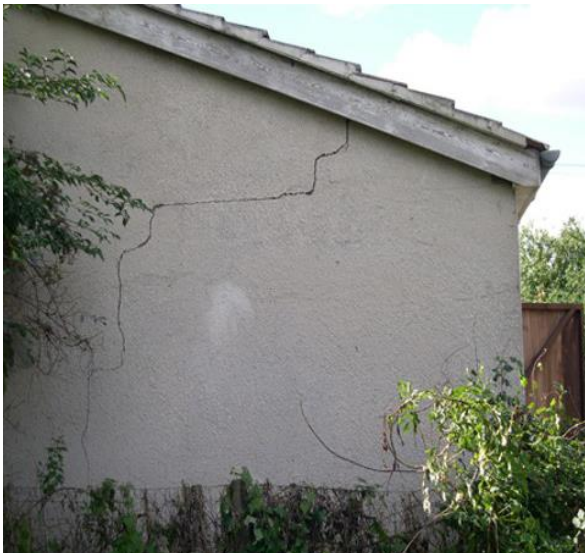
شکل ۱-۱ نمونه اثرات مخرب پدیده نشست تحکیمی بر روی سازه‌ها
