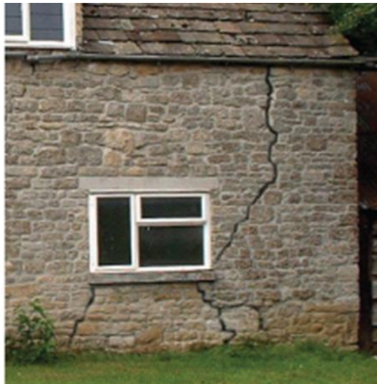
شکل ۱-۱ نمونه اثرات مخرب پدیده نشست تحکیمی بر روی سازه‌ها
