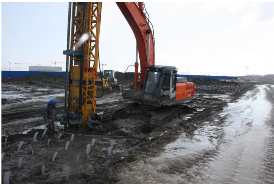
شکل ۳-۲ کارگذاری فیلترهای تخلیه‌ی آب اضافه‌ی منفذی
