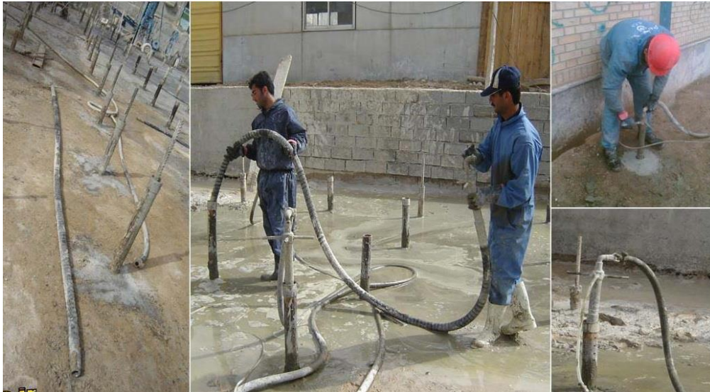
شکل ۵-۲ روند اجرای میکروپایل
