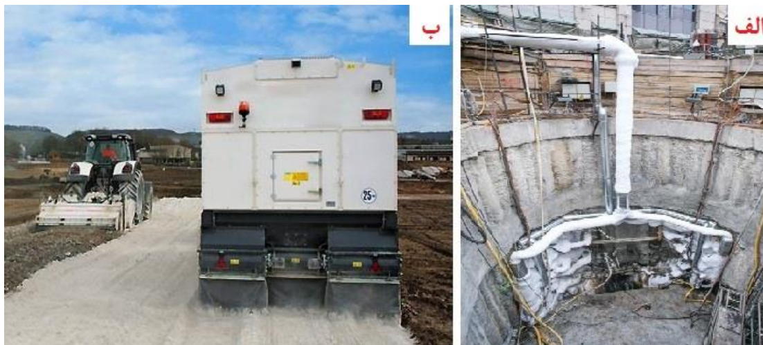
شکل ۲-۲ شکل (الف) بهسازی فیزیکی به روش انجماد خاک و شکل (ب) بهسازی شیمیایی با آهک پاشی
