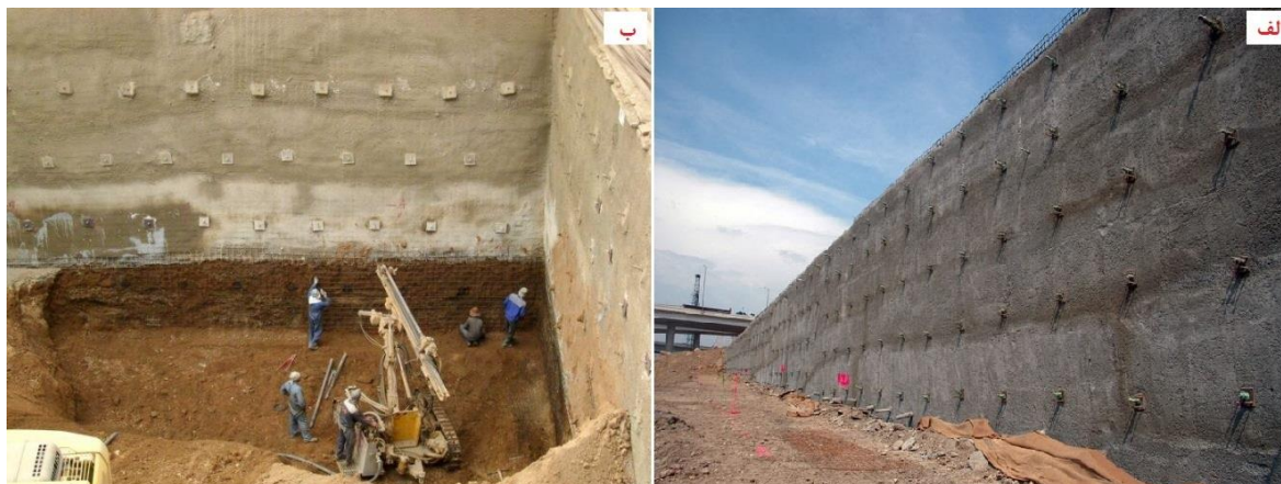
شکل ۴-۲ نمایی از اجرای نیلینگ در شکل الف و اجرای انکراژ در شکل ب
