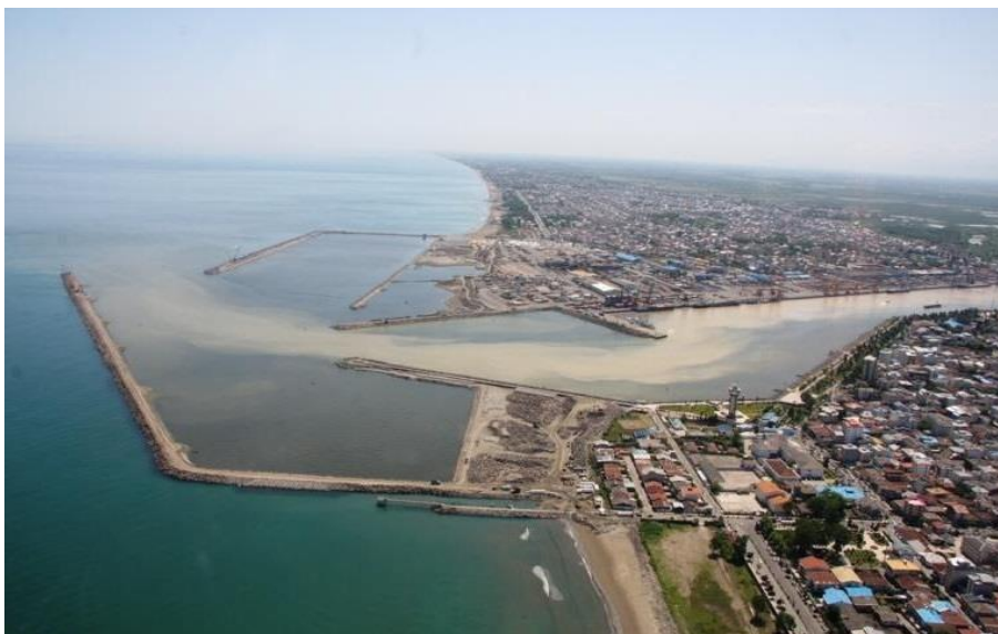
شکل ۳-۳ موج شکن بندر انزلی با به دام انداختن رسوبات، شرایط را برای استحصال زمین از دریا ایجاد می کند
