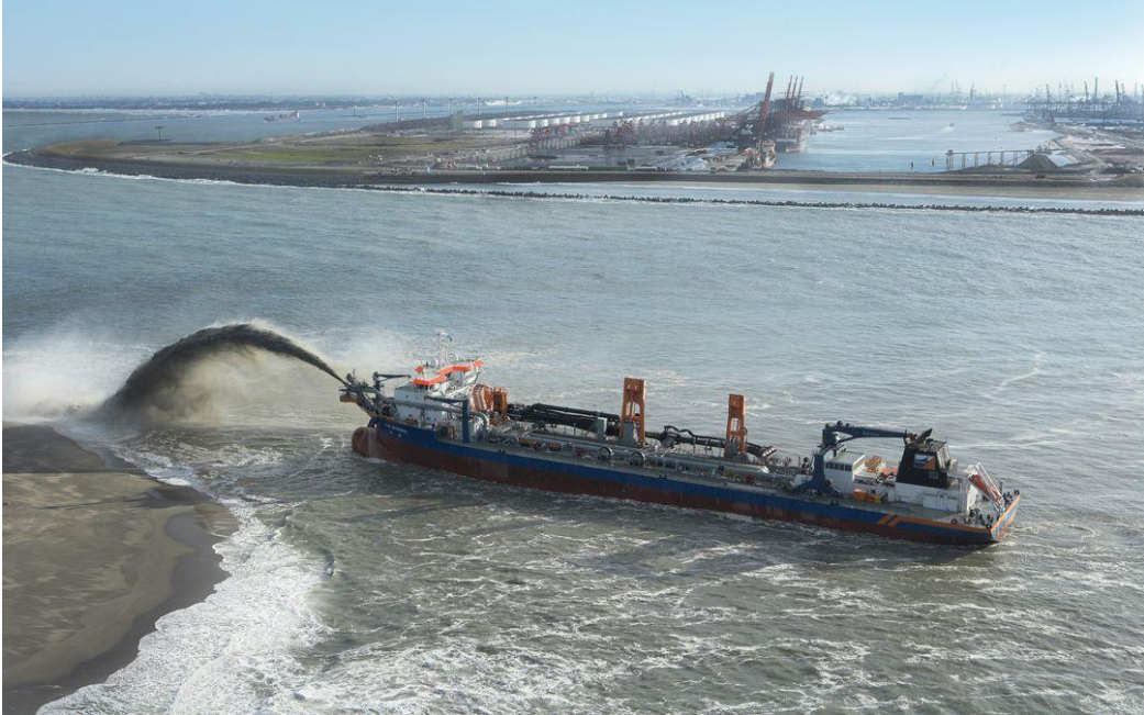
شکل ۳-۴ استحصال به روش لایروبی از دریا با سیستم Rainbow در بندر روتردام هلند با استفاده از کشتی لایروب
