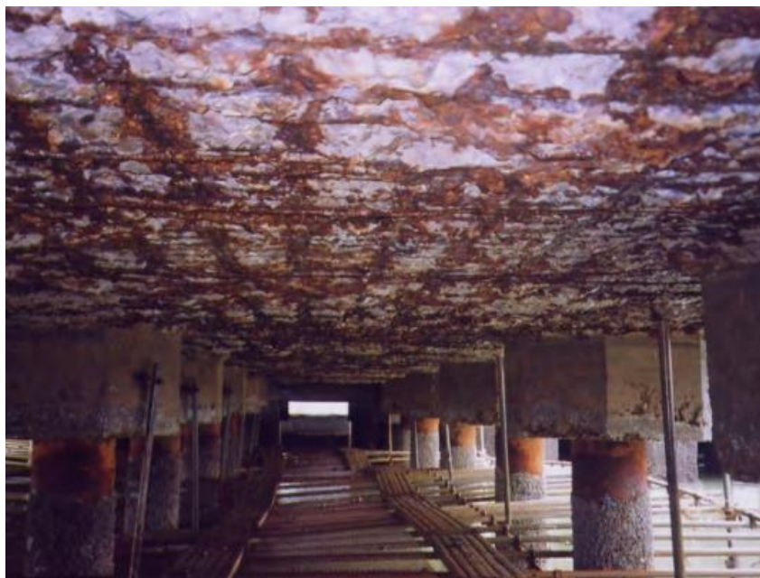
شکل ۱-۶: خوردگی آرماتور در عرشه‌های بتنی [۵]
