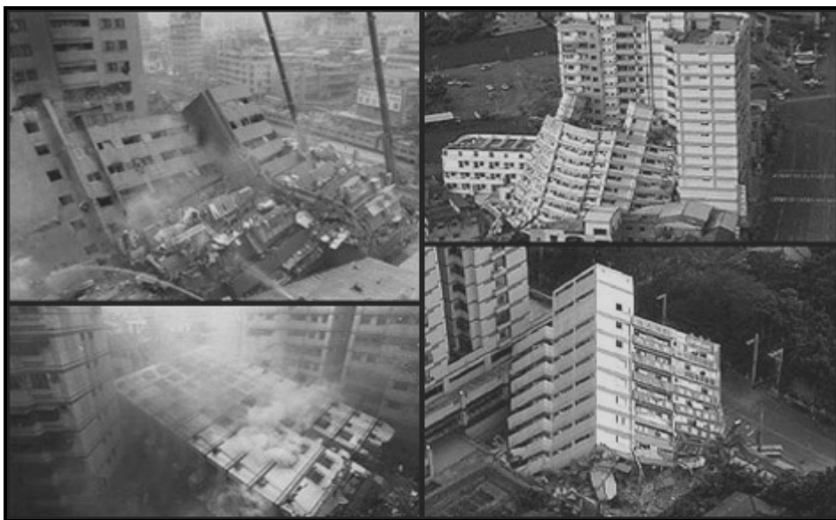
شکل ۱-۱- خرابی‌های ناشی از زمین‌لرزه
