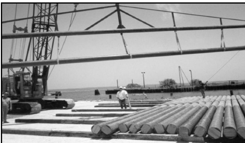
شکل ۲-۲- استفاده از کامپوزیت FRP در صنعت پایل (شمع)
