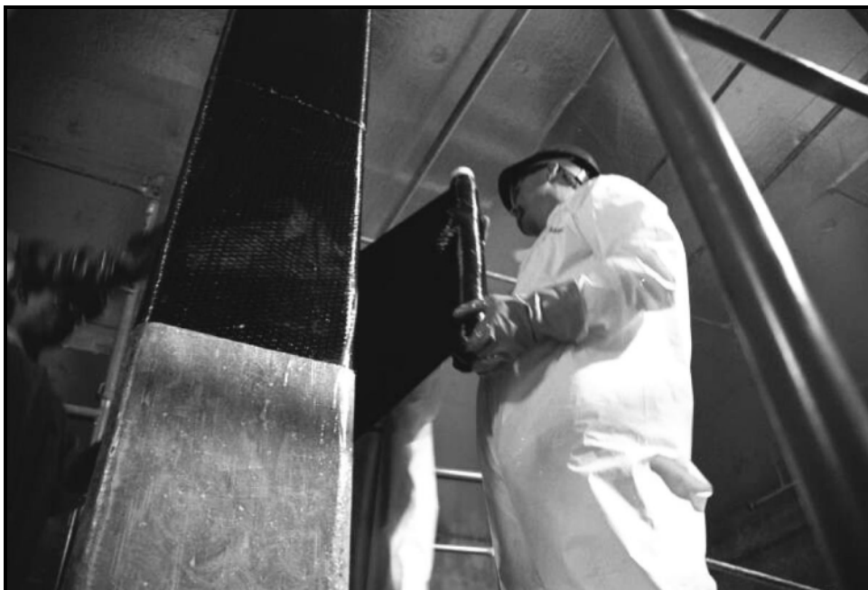
شکل ۸-۲- دورپیچ کردن ستون مستطیلی با استفاده از FRP
