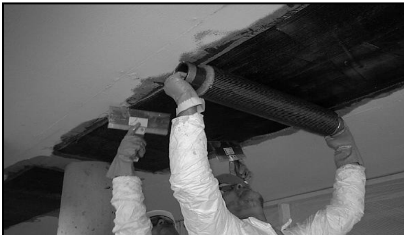
شکل ۱-۲- نصب صفحات CFRP به منظور مقاوم‌سازی خمشی تیر
