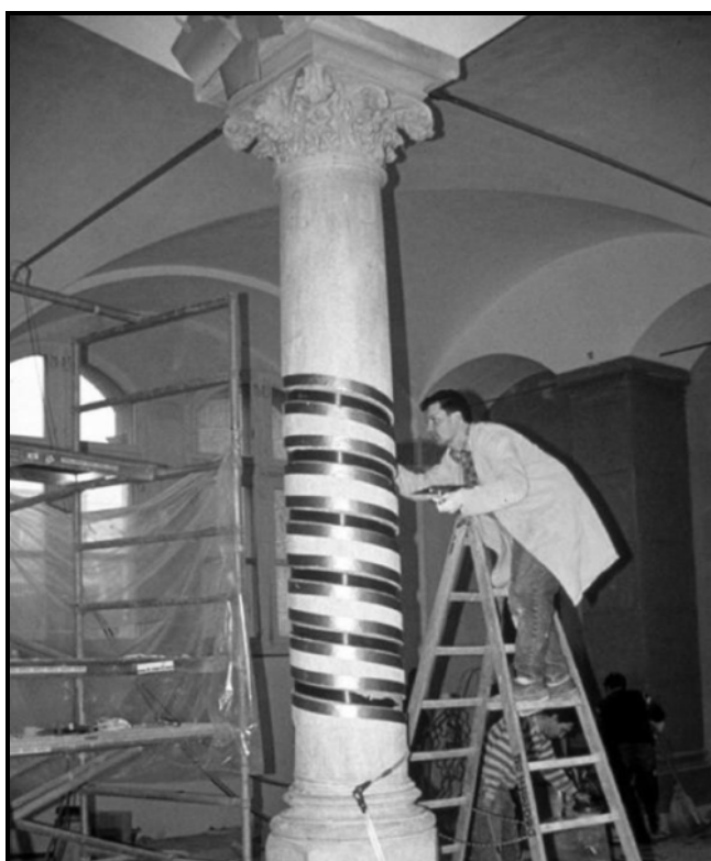
شکل ۸-۳- محصورکنندگی FRP با استفاده از نوارهای FRP از قبل عمل‌آوری شده و اجرای مارپیچ آن
