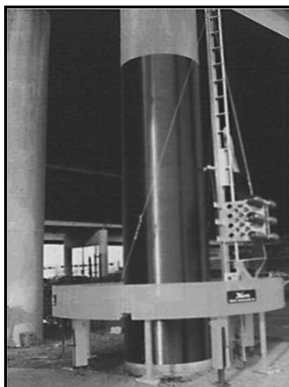
شکل ۱-۱۰- دورپیچ کردن ستون بتنی دایروی با استفاده از دستگاه‌های مکانیکی
