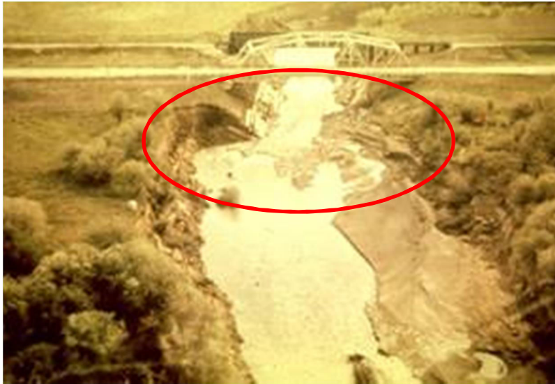
شکل ۴-۱۶. گودال به وجود آمده در بالادست رودخانه پرایری [۲۷]
