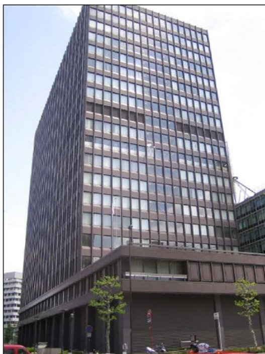
شکل ۲-۱۴- نمای از ساختمان نیپون استیل [۵]
