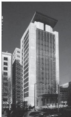
شکل ۲-۲۱- نمای ساختمان دادگاه ایالتی آمریکا، سیاتل [۸]
