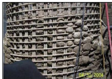
شکل ۲-۳۳: ستون پُر آرماتور اجرا شده با بتن NC [ ۱۱ ]
