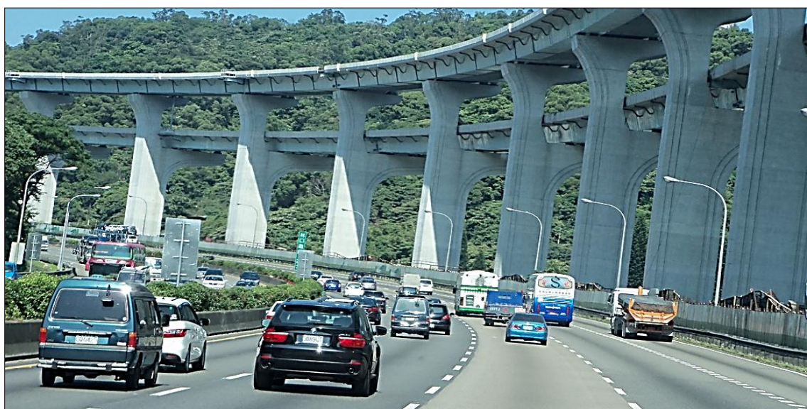
شکل ۲-۲۶: نمایی از ستون‌های اجراشده با SCC در بزرگراه Wu-Yang [۱۱]
