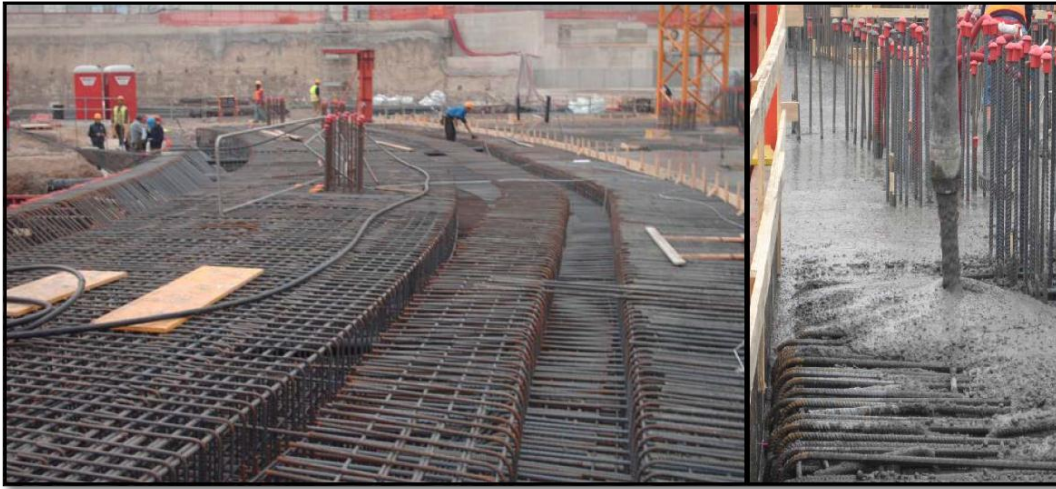
شکل ۲-۲۳: استفاده از SCC در فونداسیون آسمان خراش PORTA NUOVA [۱۱]
