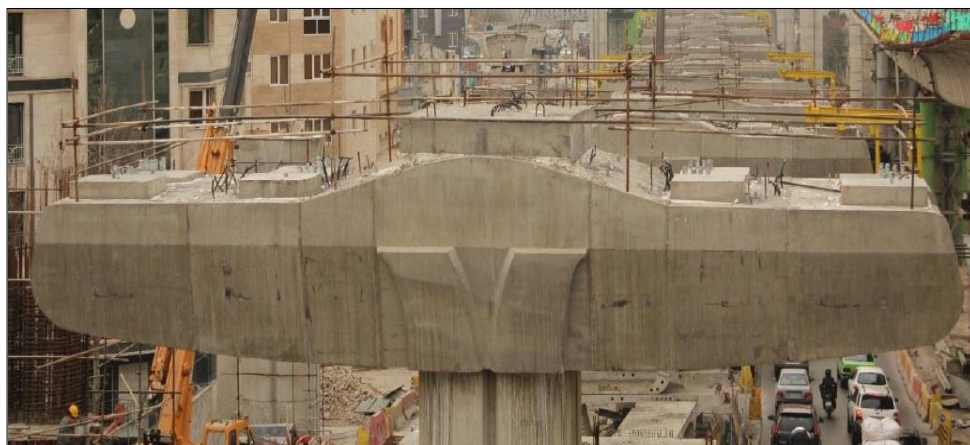
شکل ۲-۲۷: قطعات سگمنتال سرستون نصب‌شده در محور پروژه [۱۱]
