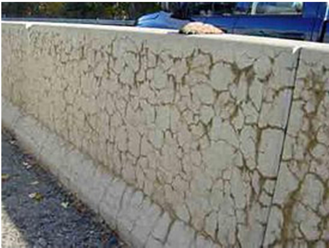
شکل ۱-۲ نمونه‌ای از واکنش قلیایی-سیلیسی در بتن
