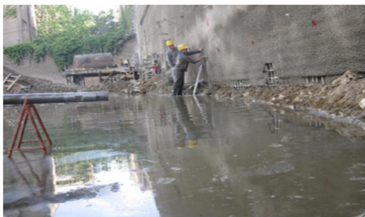
شکل ۵-۶ برخورد با لایه آبدار
