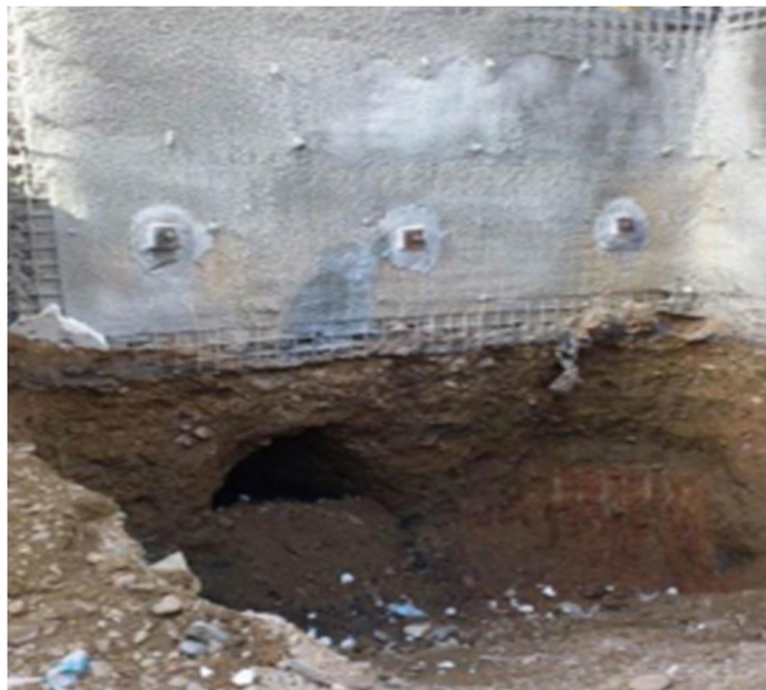
شکل ۵-۱۶ حفرات عمود بر جداره گود
