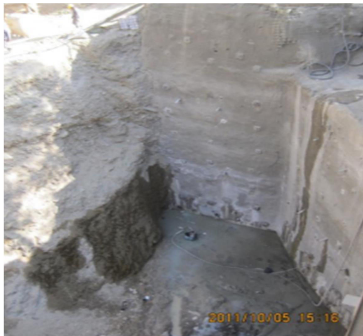
شکل ۵-۸ خروج آب از محدوده پروژه
