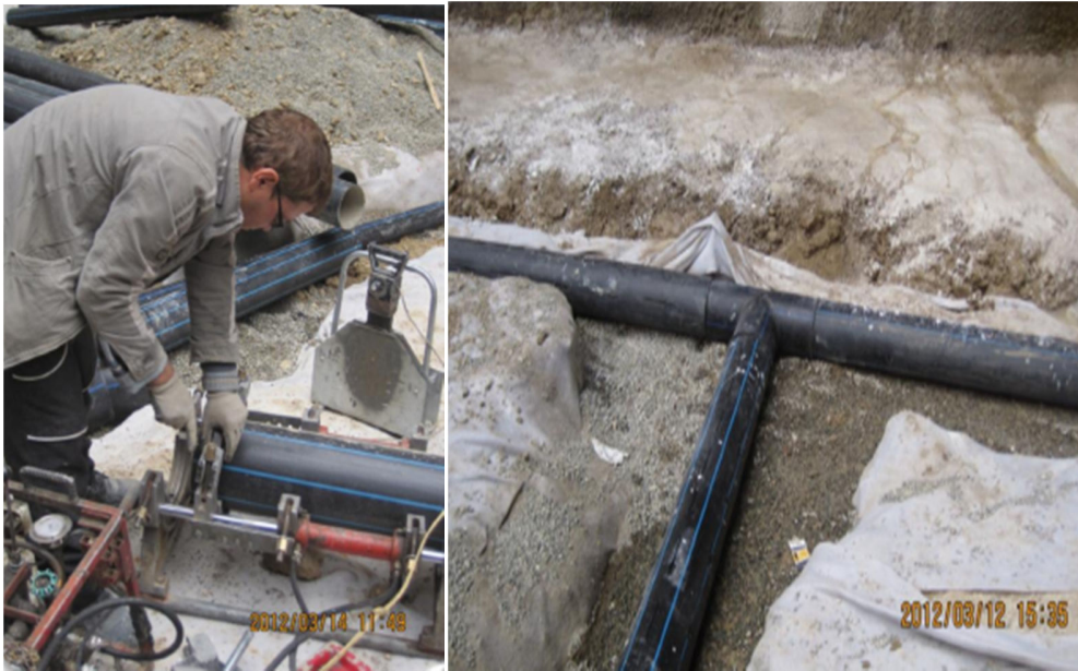
شکل ۵-۱۹ اجرای شبکه زهکشی کف
