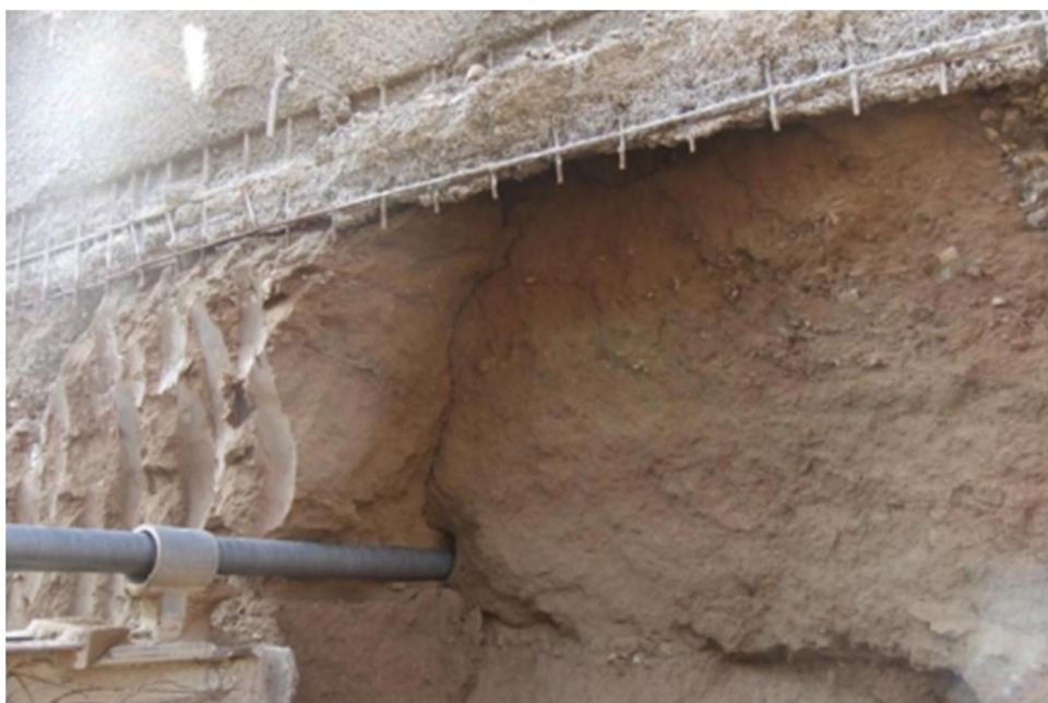
شکل ۵-۱۷ ریزش‌های موضعی به علت وجود لایه‌های سیلتی
