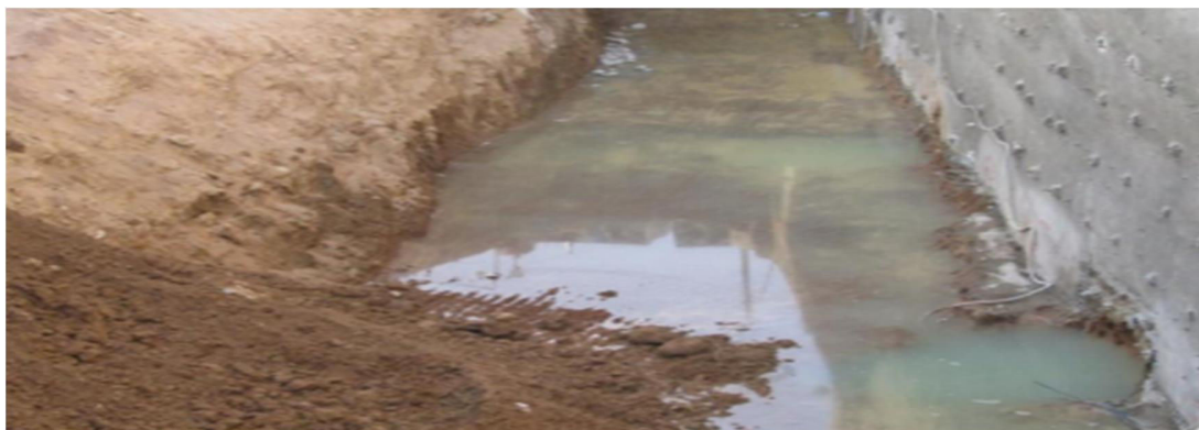
شکل ۵-۱۳ کانال کشی کف گود
