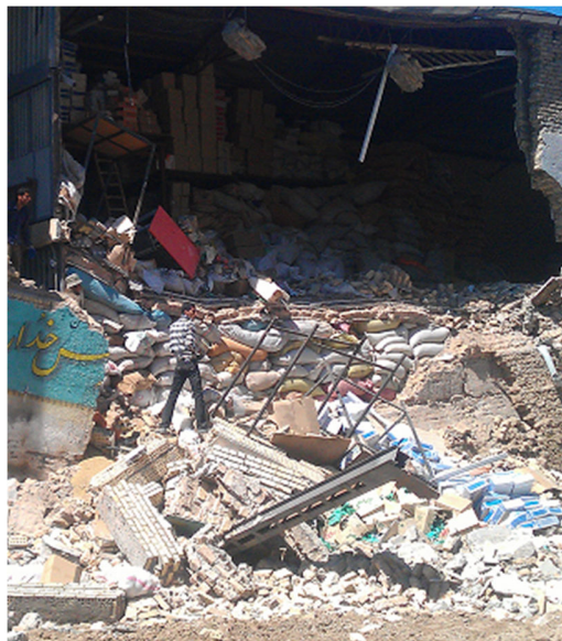
شکل ۶-۲۲. بارگذاری انبار لبه گود و ریزش دیوار پروژه چمن ۴۸
