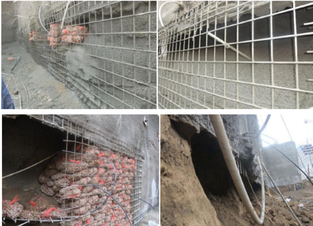
شکل ۵-۱۸ مش و شاتکریت و پرکردن با پوک و تزریق میان پوک
