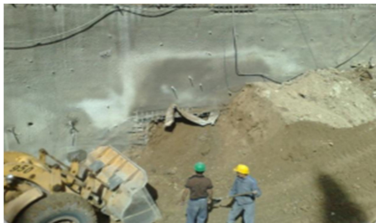
شکل ۳-۵ اجرای مش و شاتکریت بر روی دیواره
