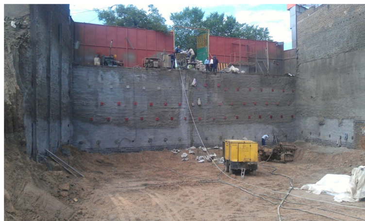
شکل ۴-۶. عملیات حفاری توسط دریل واگن
