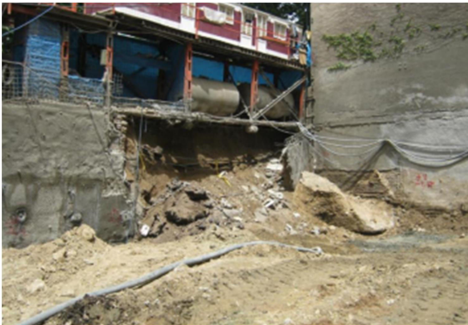
شکل ۲-۵ ریزش به علت عبور کانال تاسیسات و پر شدن اطراف آن با نخاله و خاک دستی
