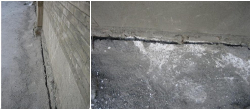
شکل ۵-۱ ایجاد ترک به دلیل وجود خاک دستی
