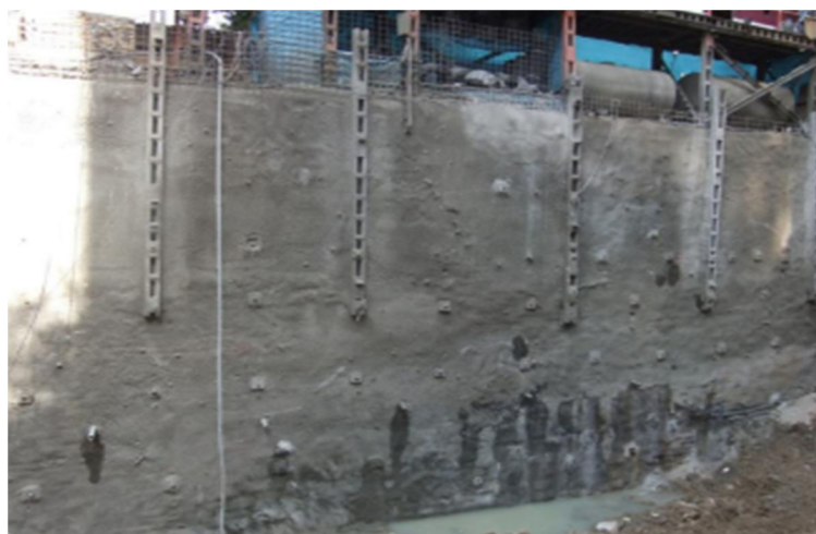
شکل ۴-۵ اجرای ستون‌های فلزی
