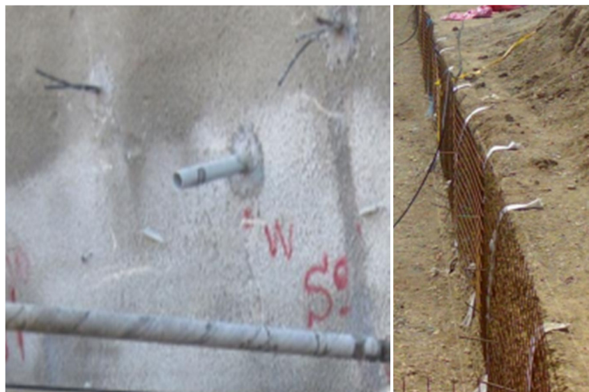
شکل ۵-۵ اجرای المان‌های زهکشی در دیواره
