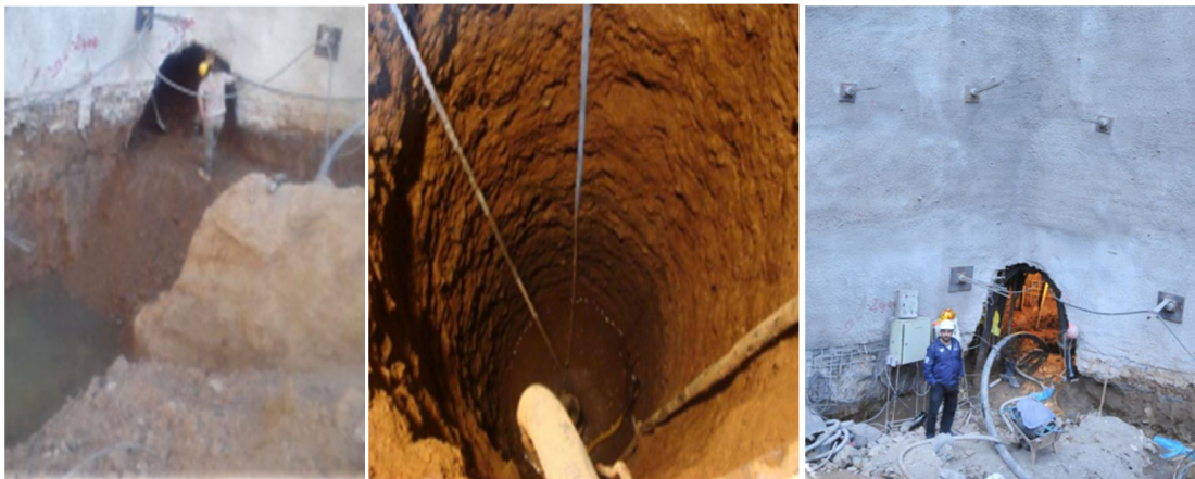
شکل ۵-۱۱ اجرای چاه‌های زهکش و گالری پیرامونی به همراه پمپاژ دائمی آب
