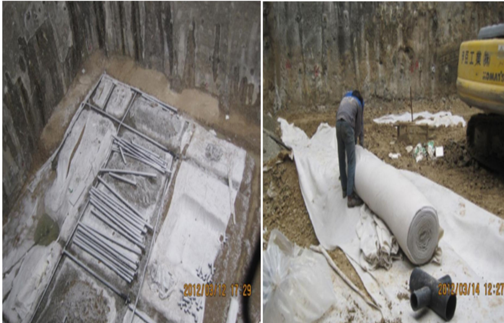
شکل ۵-۱۰ اجرای شبکه زهکشی کف
