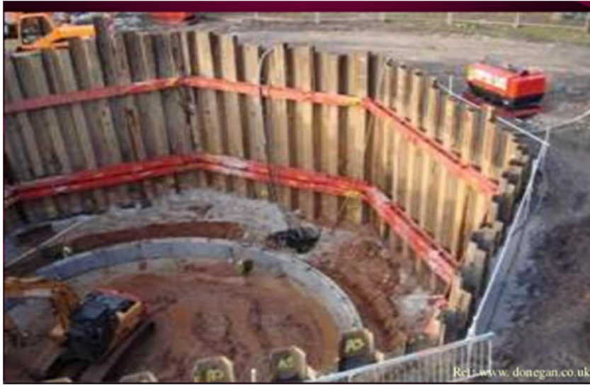
شکل ۲-۶ روش سپر کوبی [۵۶]
