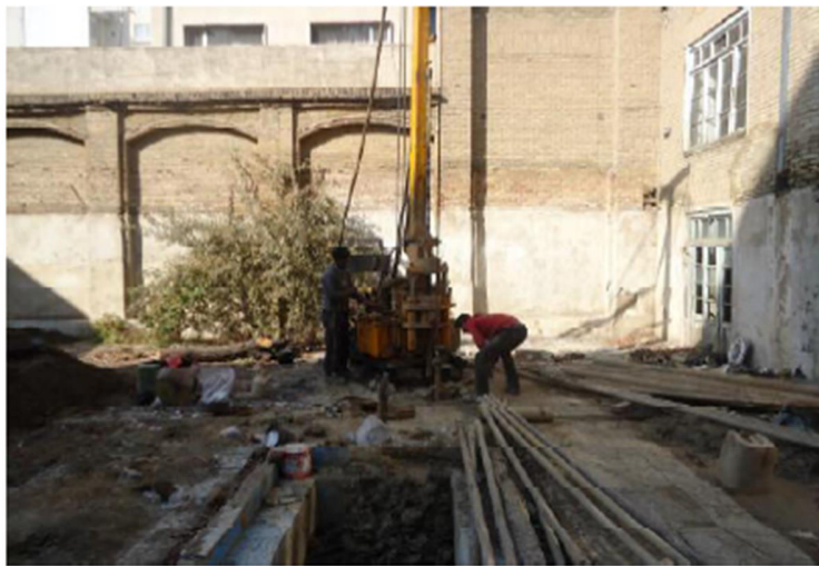
شکل ۶-۱۴. حفاری گمانه مطالعاتی پروژه حسینیه قمی‌ها
