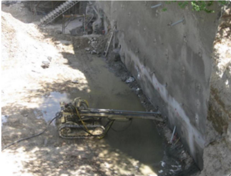
شکل ۵-۷ برخورد با لایه آبدار و حفاری گمانه
