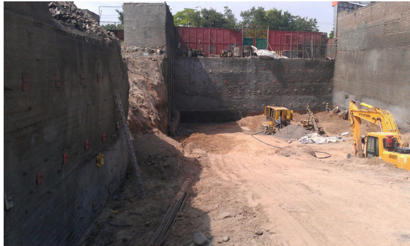
شکل ۳-۶. اجرای شاتکریت دیوارها پروژه برج سبز
