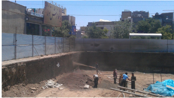
شکل ۶-۲۳. اجرای شاتکریت در ضلع شمالی پروژه چمن ۴۸
