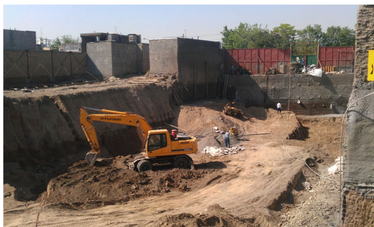
شکل ۶-۶. مش بندی دیواره جهت اجرای شاتکریت
