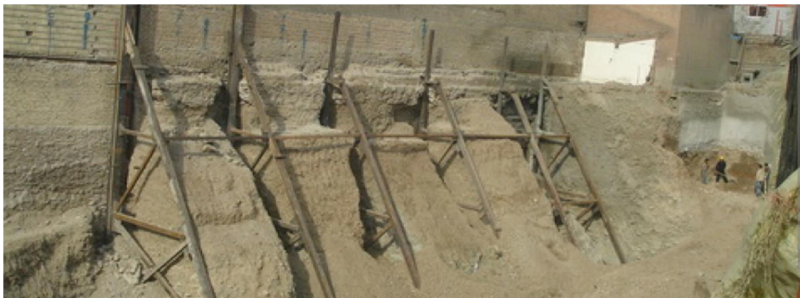
شکل ۲-۷ روش خرابایی [۵۴]
