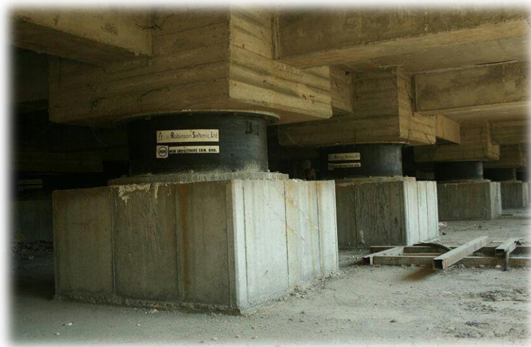
شکل ۲-۴- نمونه‌ای از سیستم جدا ساز پایه
