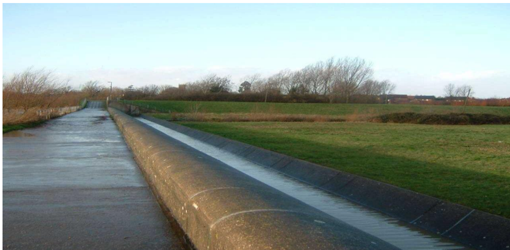
شکل (۱-۳) نمونه ای از سرریز جانبی
