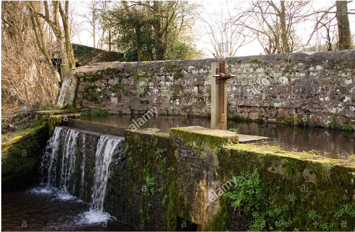
شکل (۱-۴) نمونه ای از سرریز جانبی
