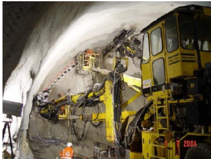
شکل (۵-۲۰): حفاری و نصب فورپولینگ با جامبو دریل
