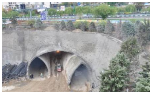
شکل (۶-۵): نمونه‌ی اجرا شده از این مقطع در تونل صدر- نیایش
