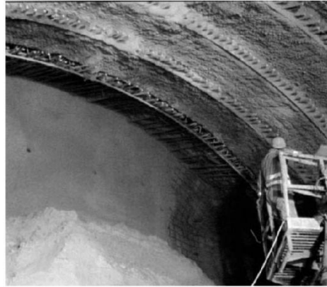
شکل (۵-۲۱): نمایی از اجرای S-Pile از بین لتیس‌گریدرها در هر گام حفاری
