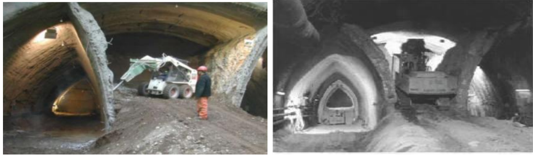
شکل (۷-۵) : نمونه‌ی اجرایی از روش گالری‌های کناری
