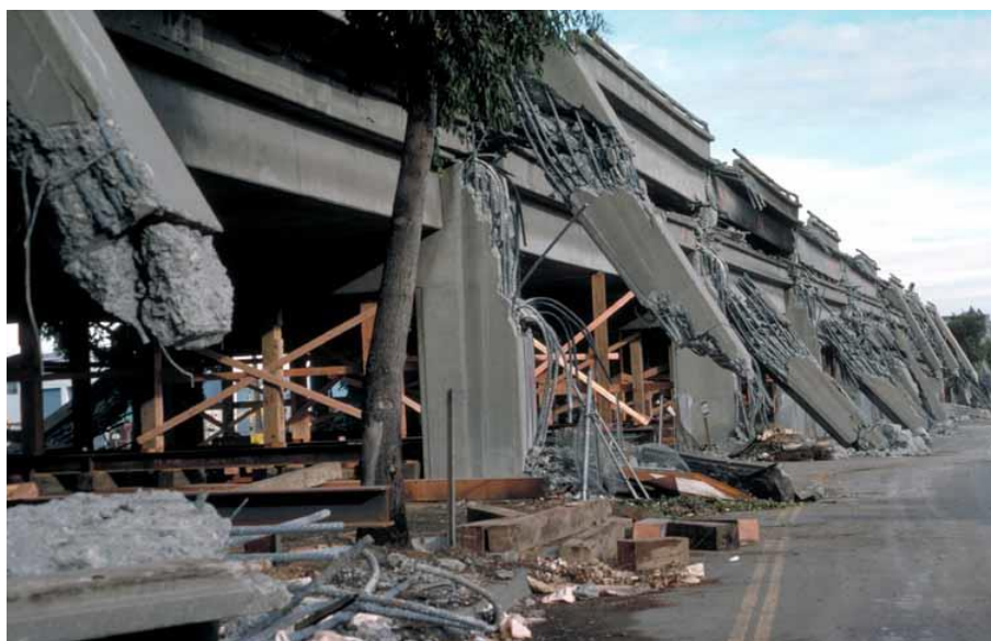
شکل (۳-۱) مشاهدات گسیختگی شمع های مایل زلزله Loma Prieta در سال ۱۹۸۹ [۲]
