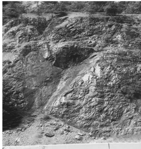
شکل ۲-۳ نمونه ای از گسیختگی گوه‌ای در نزدیکی شهر Grants Pass, Oregon در کشور آمریکا [۳].
