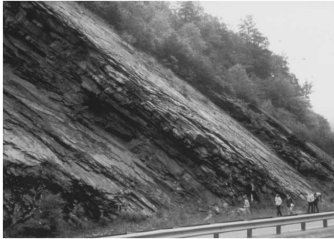
شکل ۱-۲ گسیختگی صفحه‌ای در ایالت Tennessee در کشور آمریکا [۳].
