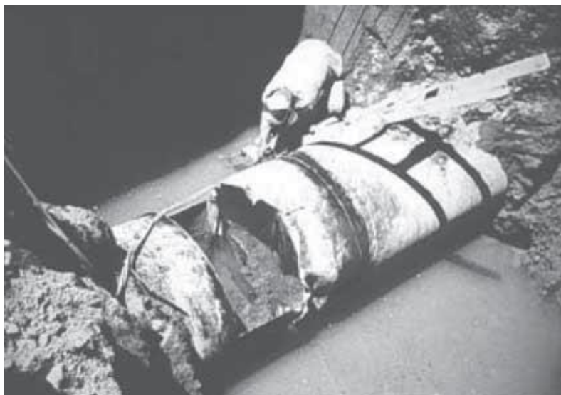
شکل ۲-۱ گسیختگی یک لوله فولادی در زلزله Mexico City [۲].
