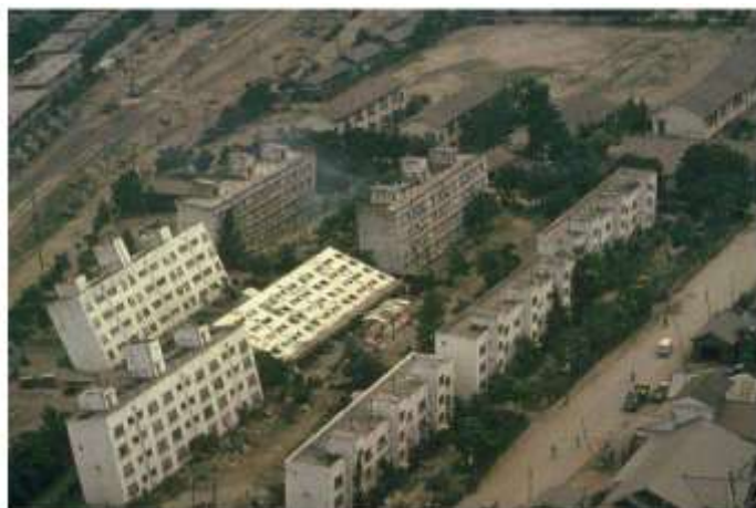
شکل ۲-۴ اثر روانگرایی بر سازه‌ها در زلزله نیگاتای ژاپن (نشریه شماره ۵۲۵، ۱۳۹۱)
