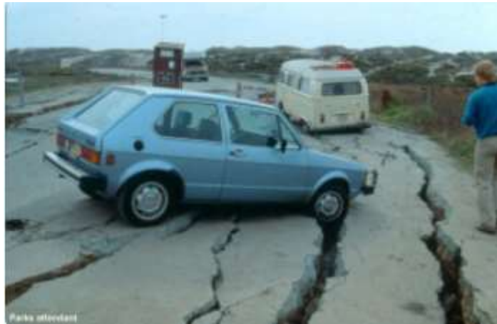
شکل ۲-۳ گسترش جانبی و نشست ناشی از روانگرایی در کویسک (kiosk)
