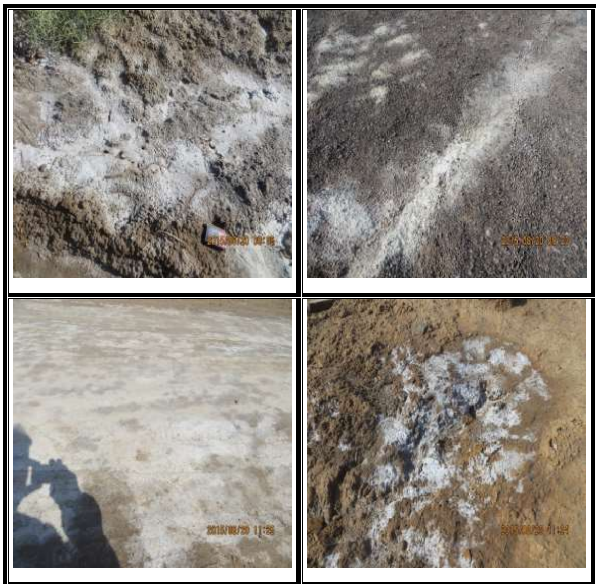
شکل ۳-۱: تراوش نمک به سطح زمین
