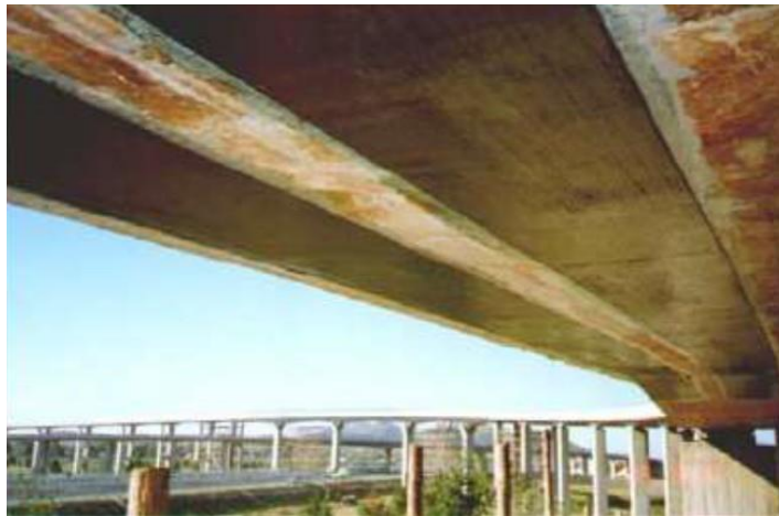
شکل ۱-۳- مقاومت‌سازی خمشی دال‌های پل بتن مسلح بزرگراهی در چین [27]
