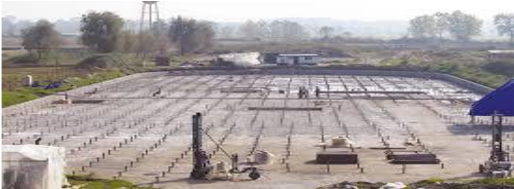
شکل ۱۰-۲- تثبیت بروش جایگزینی
