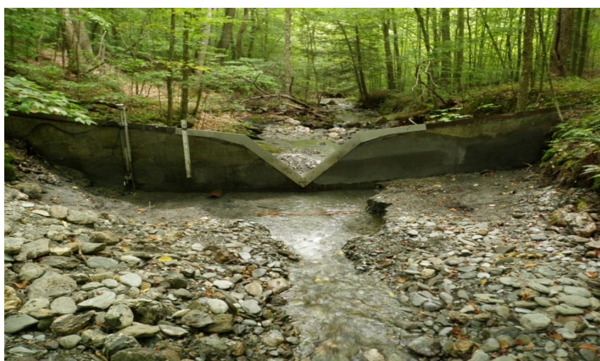
ج) سرریز مرکب مثلثی-مثلثی شکل (۷-۱) نمونه هایی از سرریز مرکب
