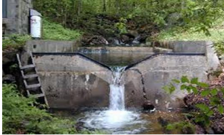
شکل (۱-۴ب): نمونه‌ای از سرریز نرمال مثلثی
