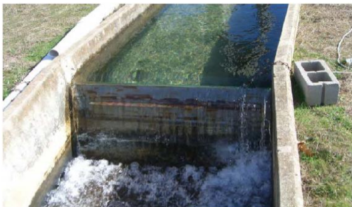
شکل (۱-۴ الف): نمونه‌ای از سرریز نرمال مستطیلی
