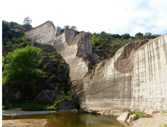
شکل ۱-۴: شکست سد مالپاست فرانسه - ۱۹۵۹
