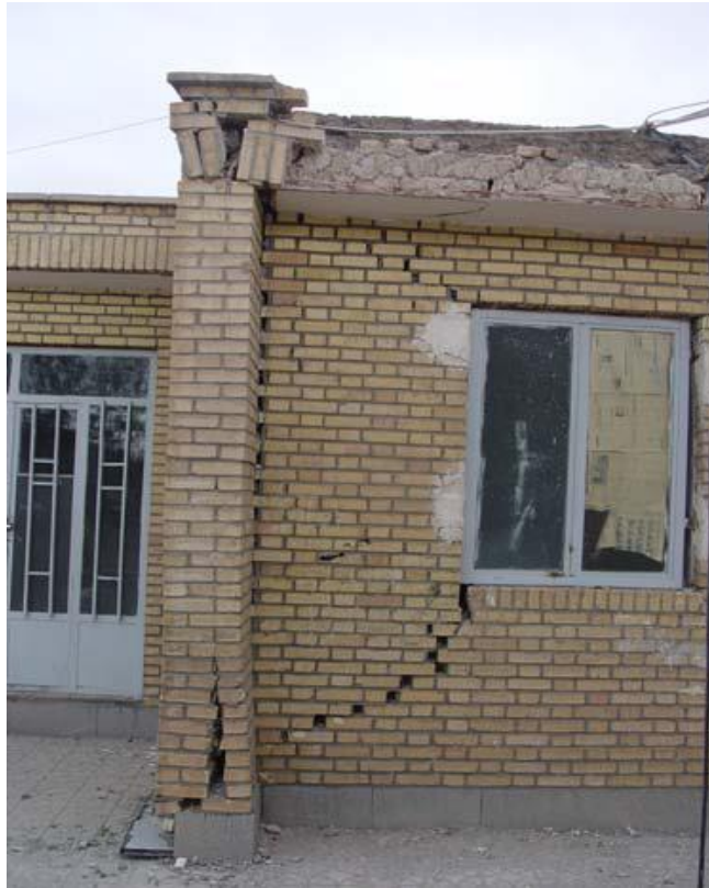
شکل (۱-۱) فاصله \frac{۲}{۳} ارتفاع بازشو از انتهای دیوار رعایت شده است
