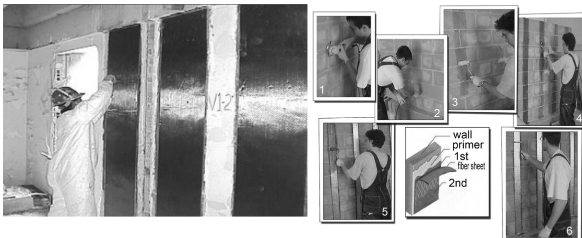
شکل (۱-۱۳) دیوار تقویت شده با FRP [۶]
