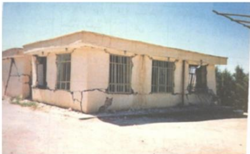
شکل (۹-۱) شکست تحت نیرو افقی
