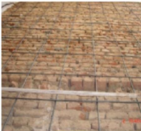
شکل (۱-۱۲) دیوار تقویت شده با شاتکریت [۶]
