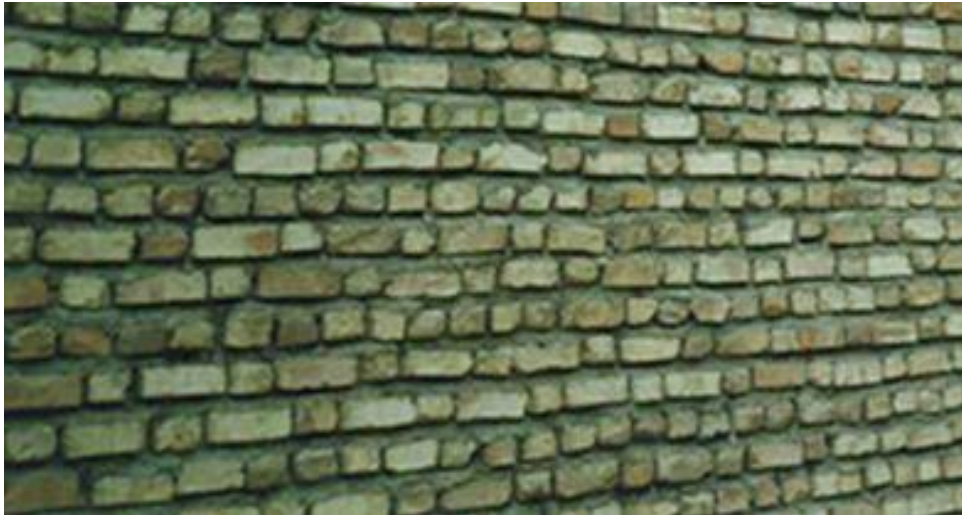
شکل (۸-۱) از بین رفتن ملات بین رج‌ها
