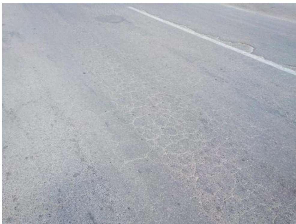
شکل (۵-۴) خ معلم واحد شماره ۸۶، ترک پوست سوسماری
