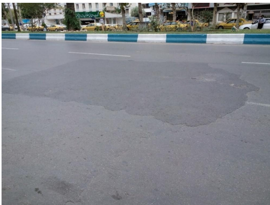
شکل (۴-۱) بلوار آزادی واحد شماره ۱، وصله کاری
