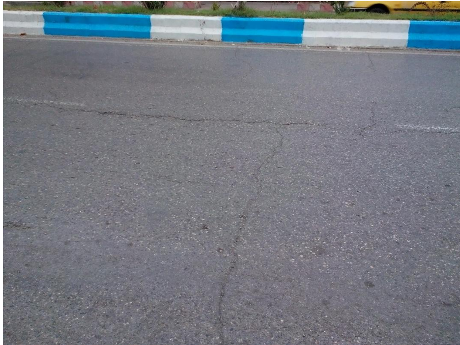
شکل (۴-۱۰) بلوار آزادی واحد شماره ۲، ترک عرضی و طولی
