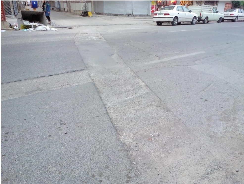
شکل (۴-۴) خ قارن واحد شماره ۵۸، وصله کاری
