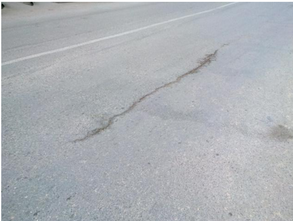
شکل (۹-۴) خ معلم واحد شماره ۹۲، ترک طولی
