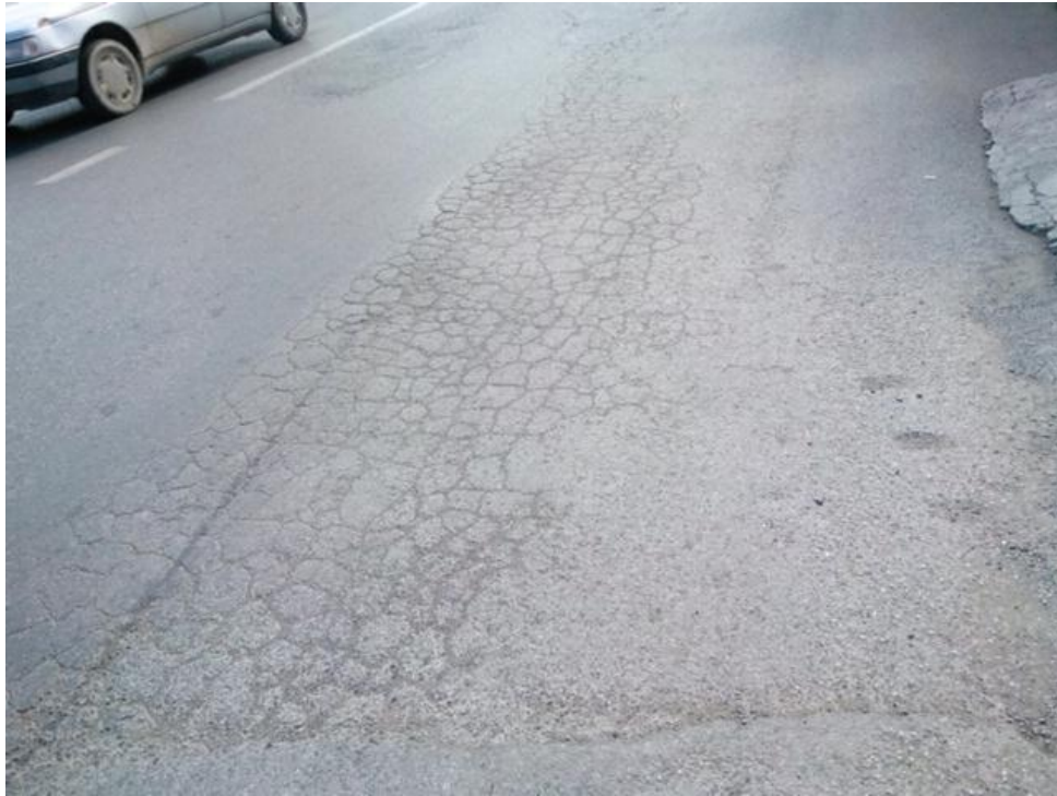
شکل (۸-۴) خ جهان آرا واحد شماره ۱۰۶، ترک پوست سوسماری
